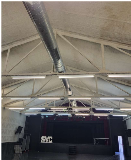
Figura 1. Sistema actual de climatització per conductes
