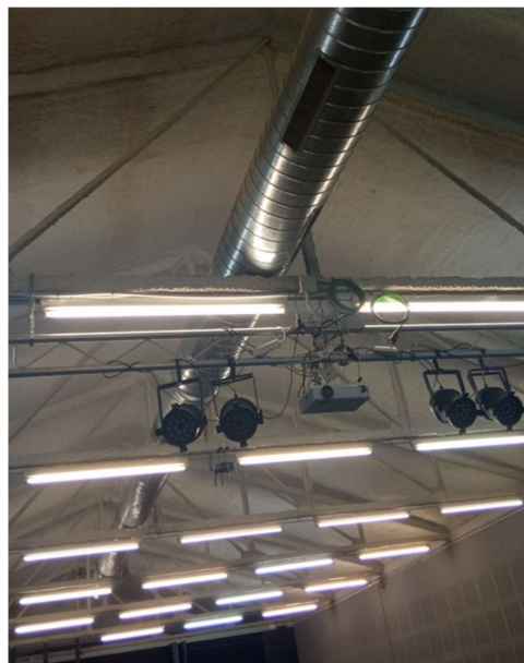
Figura 3. Detall interior de la coberta
