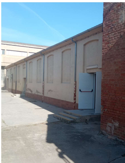
Figura 5. Vista general de l'equipament
