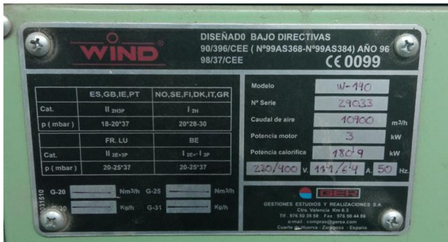
Imatge 2: característiques tècniques del sistema de calefacció
