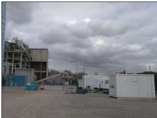
Fotografía 1: Vista de la zona de implantación de la planta de tratamiento de agua
