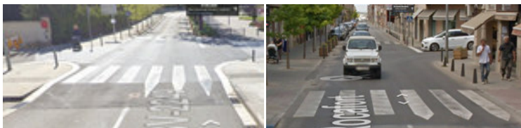
Plataforma reductora de velocitat en cruïlla
