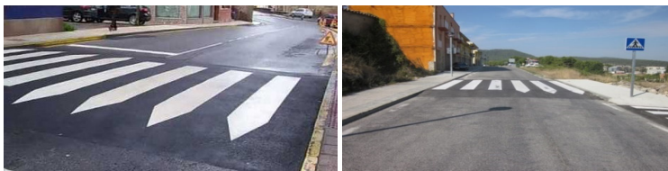
Pas de vianants elevat
