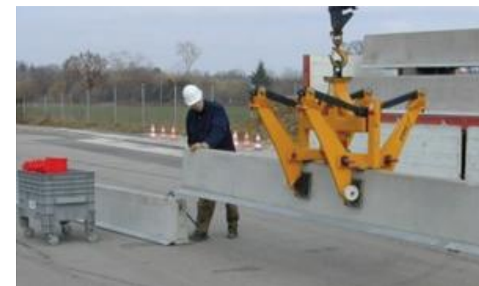
Colocación de pretil prefabricado mediante pinzas de levantamiento
