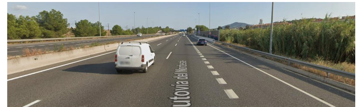
Imagen de la sección actual de la autovía A-2 en el tramo de actuación
