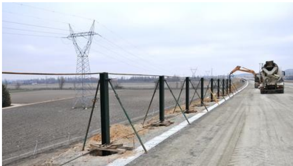
Detalle de Montaje de perfiles de soporte y paneles
