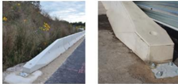
Ejecución anclaje final
