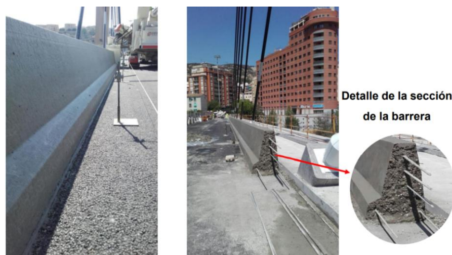
Detalle de ejecución de barrera de hormigón in situ
