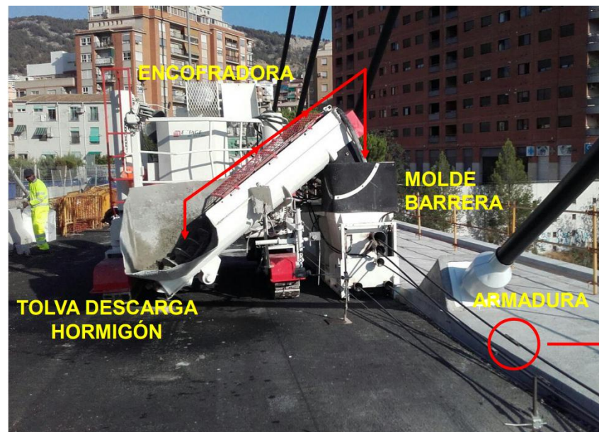
Detalle de encofradora deslizante
