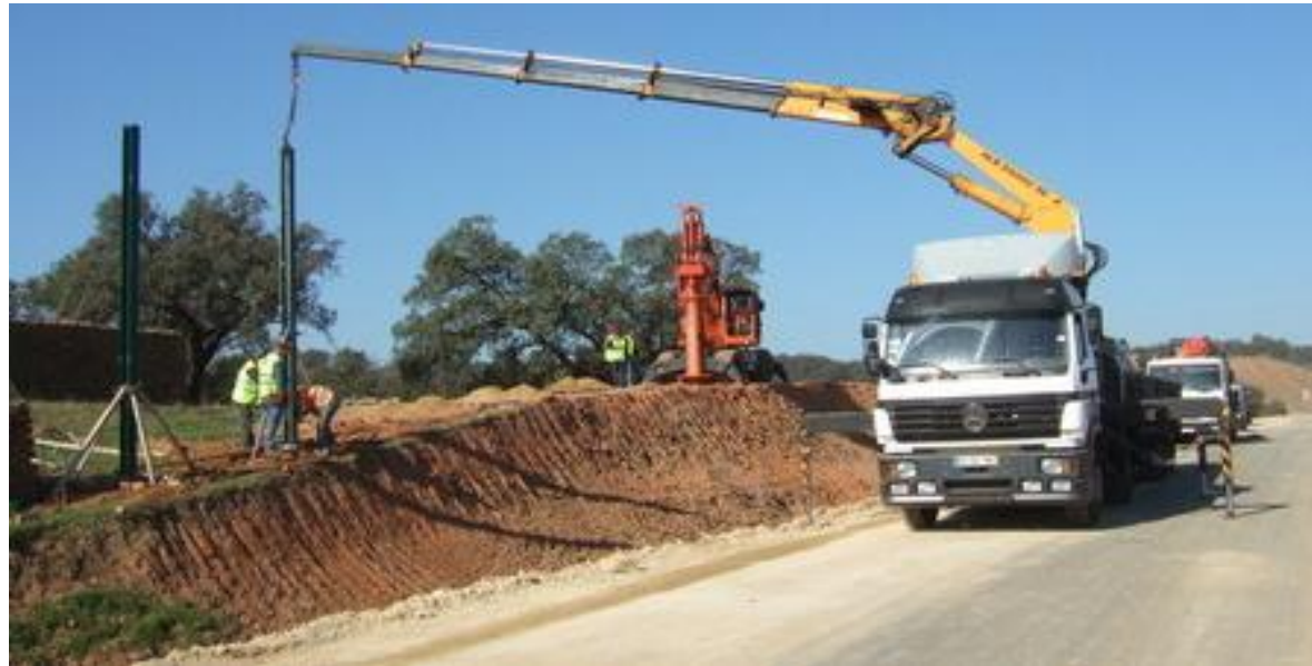
Detalle de Montaje de perfiles de soporte y paneles
