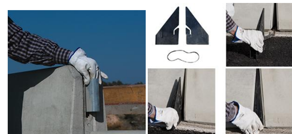
Unión entre barreras mediante pieza de acoplamiento. Instalación de cuñas de goma
