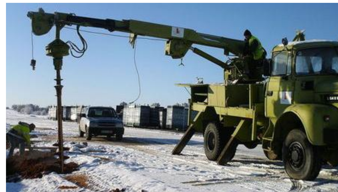
Detalle de ejecución de cimentaciones (perforación del terreno)
