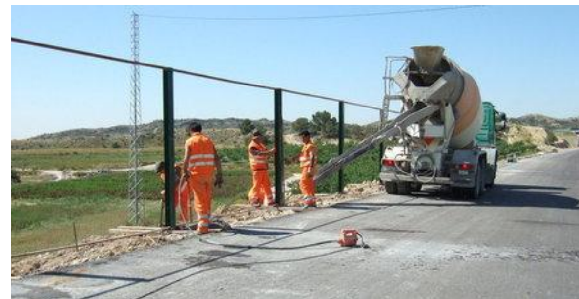
Detalle de ejecución de cimentaciones (hormigonado)
