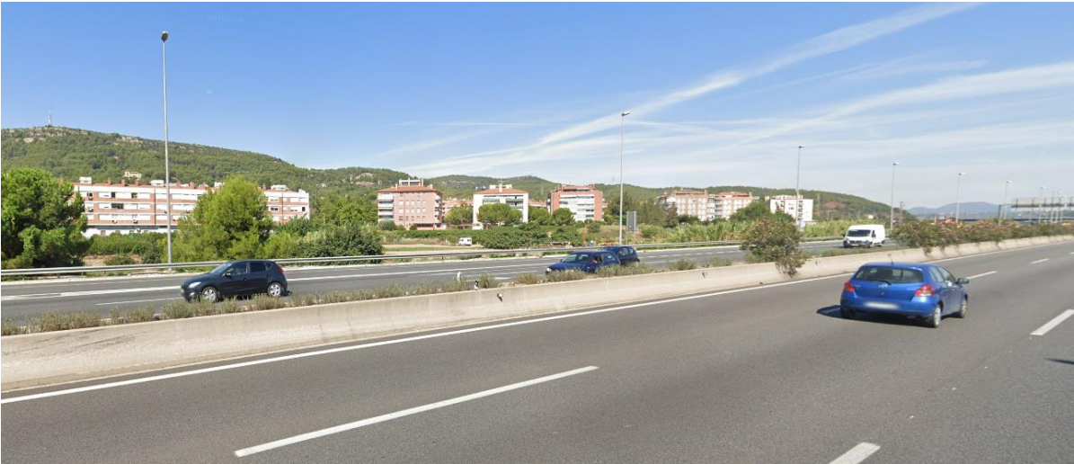
Vista general de los obstáculos al viento en el ámbito del proyecto
