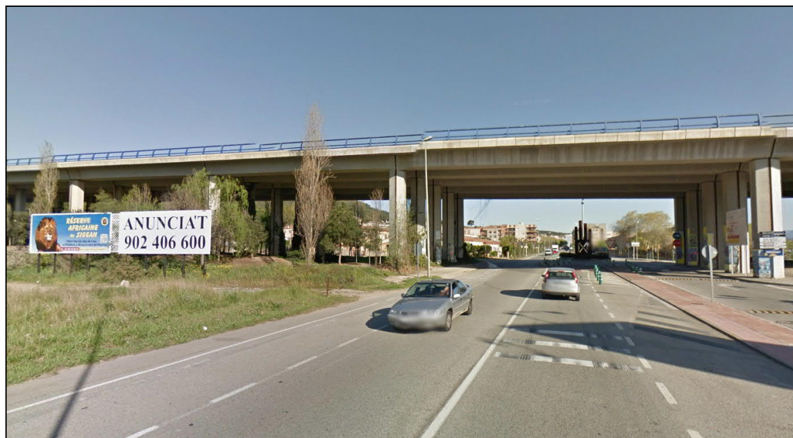
Imatge 15: Viaducte de la B-24 sobre la N-II a Paldejà.
