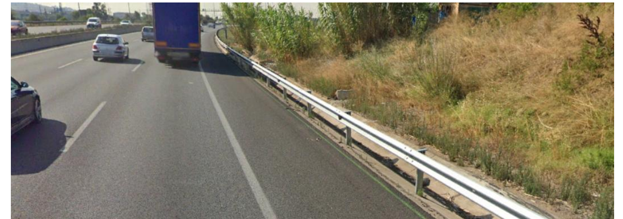
Cuneta triangular de desmante existente en el ámbito de actuación
