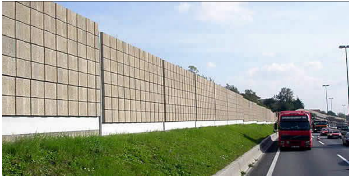
Imatge 23: Exemple d'apantallament acústic lineal. Font: Climablock.
