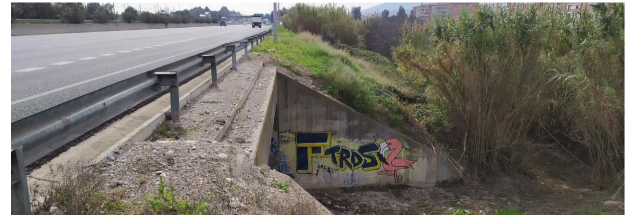
Bordillo existente en el ámbito de actuación
