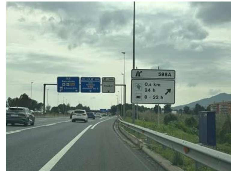
PK 0 + 545 → Señal de orientación (se valorará en obra la no afectación de la señal mediante el replanteo de las pantallas acústicas)
