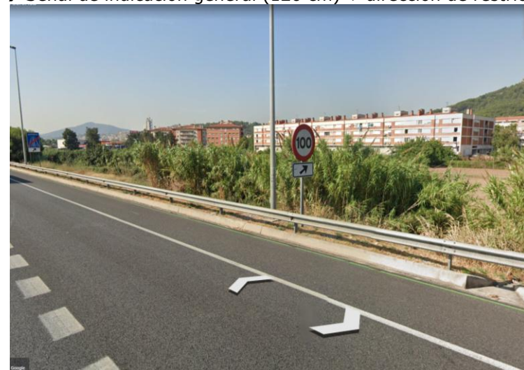
PK 0 + 440 → Señal R-301 (M-120 cm) + indicación de dirección de restricción (120 cm).
