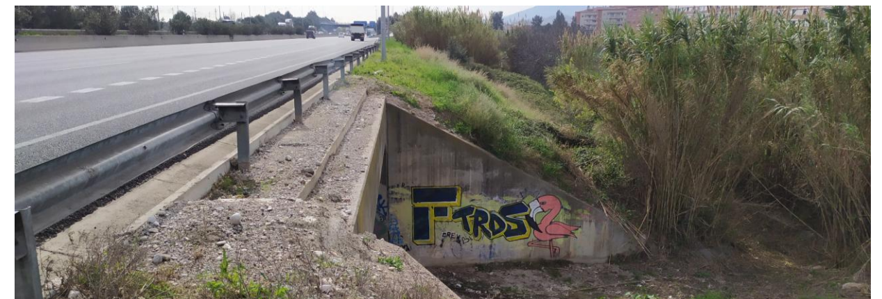
Bordillo existente en el ámbito de actuación
