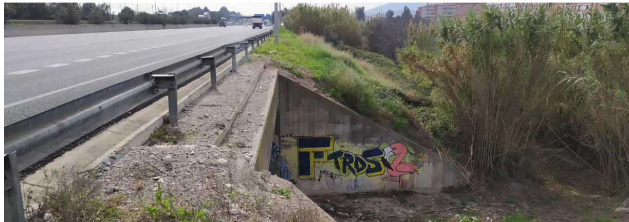
Bordillo existente en el ámbito de actuación
