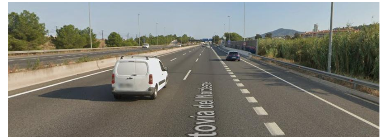
Imagen de la sección actual de la autovía A-2 en el tramo de actuación
