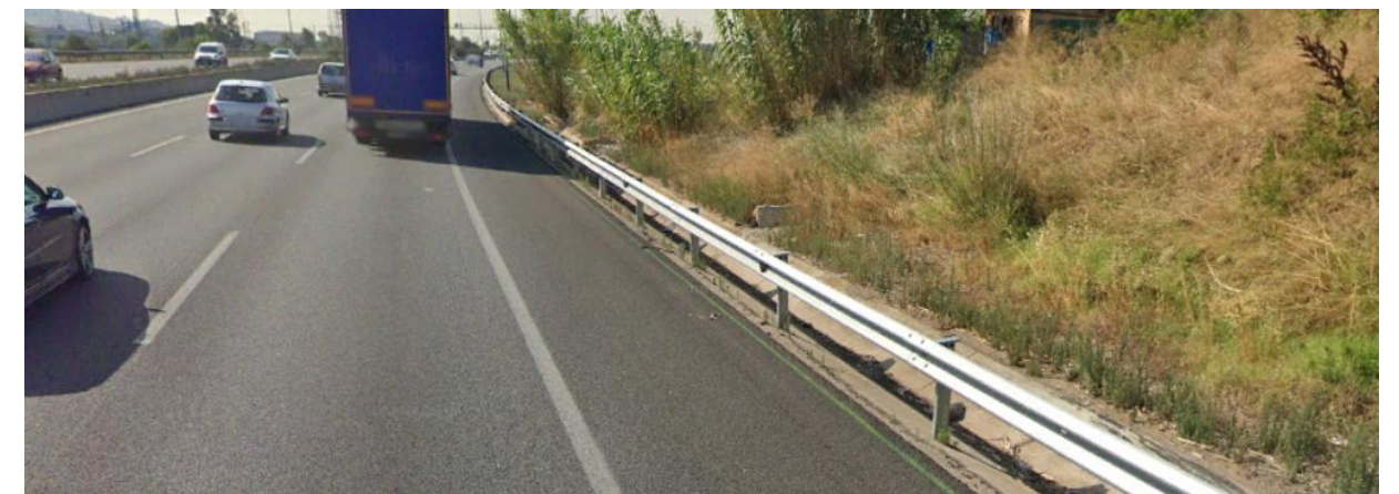
Cuneta triangular de desmonte existente en el ámbito de actuación
