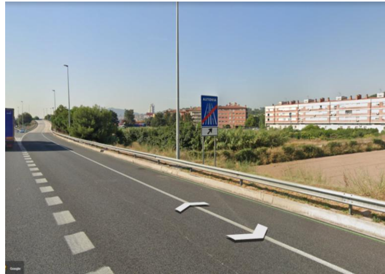
PK 0 + 400 → Señal de indicación general (120 cm) + dirección de restricción (120 cm)
