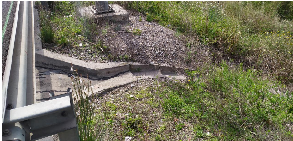
Bajante existente en el terraplén en el ámbito de actuación
