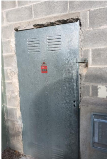
Il·lustració 2: Porta caseta dipòsit
