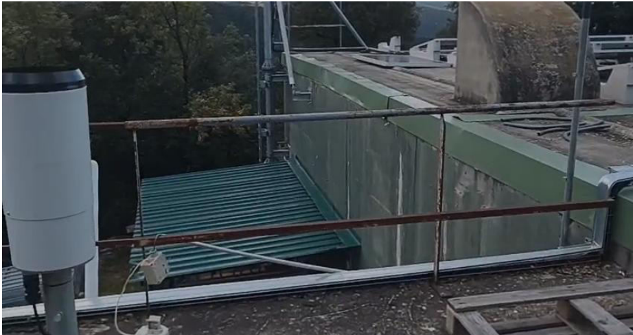
Il·lustració 3: Barana ETAP-dipòsit
