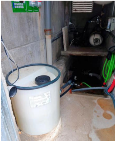
Il·lustració 7: Clor emmagatzemat a zona quadres electrics
