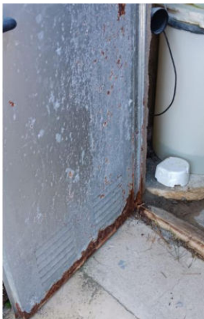
Il·lustració 7: Clor emmagatzemat a zona quadres electrics
