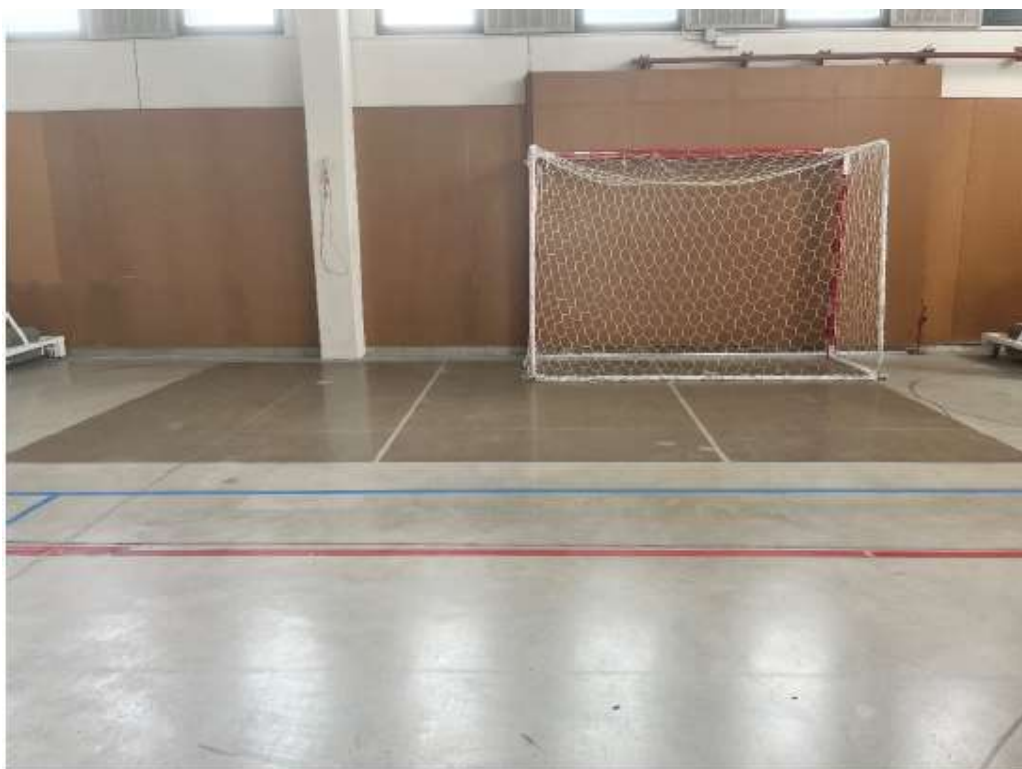
Imatge 5: reparació en paviment existent
