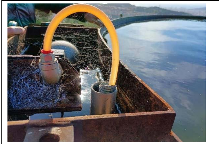
Imatge 24: Exemple del sistema d'abastiment automàtic amb boia de control i punt de captació al camí d'accés als camps
