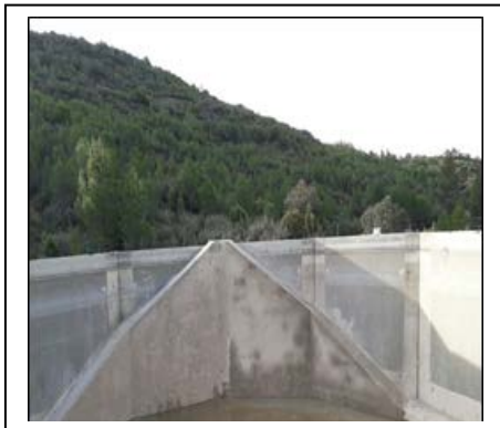
Imatge 25: Rampa de fauna d'obra per punt d'aigua.
