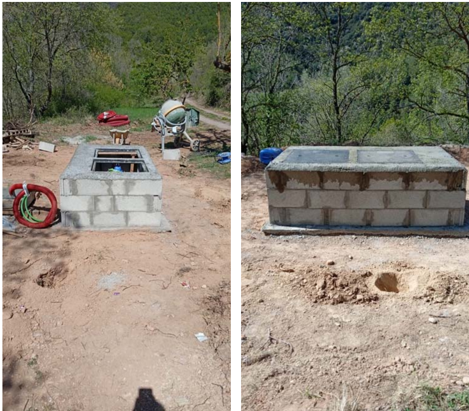
3 Inici de projecte. Arqueta del pou nou de Cal Marc d'abastament en alta a el Sàlzer i, en previsió, a la Valldan
