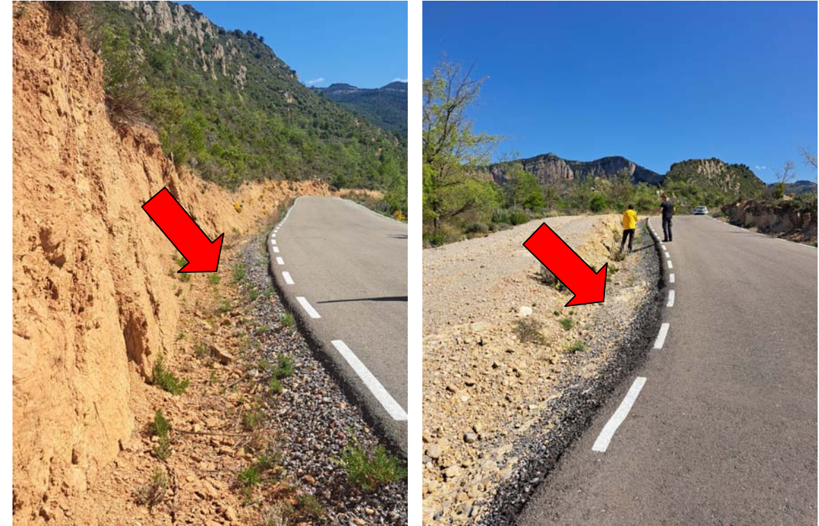
7 Camí de la Valldan. El nou tub d'abastament en alta de la nova xarxa passarà per la cuneta esquerra, és a dir, baixant, a la dreta
