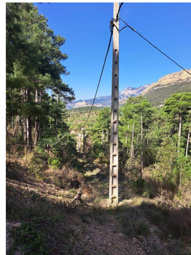
11 Línia elèctrica a la zona de Ca l'Espinal, per connexió de la nova escomesa elèctrica de les instal·lacions del nou dipòsit
