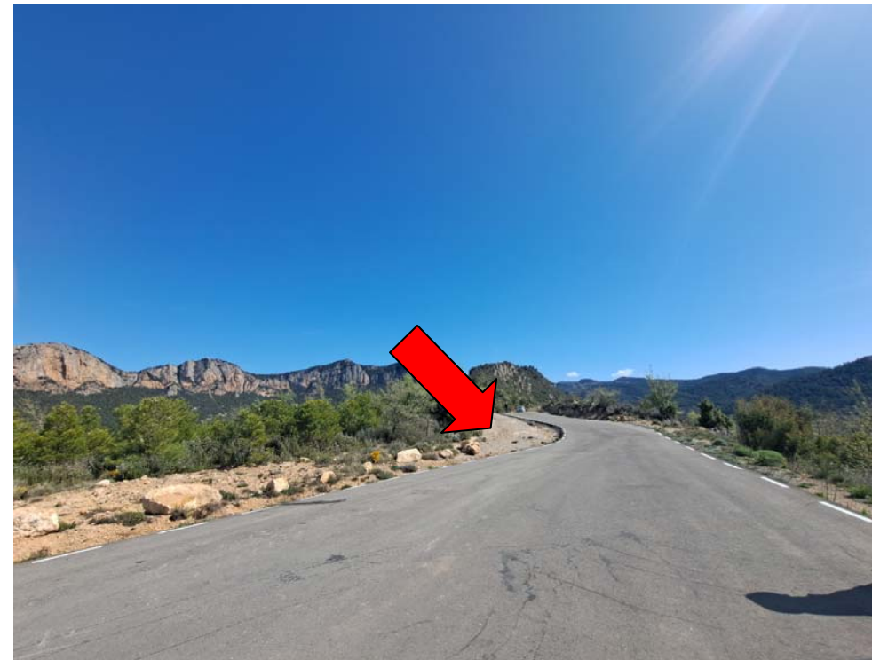
8 Camí de la Valldan. El nou tub d'abastament en alta de la nova xarxa passarà per la cuneta esquerra, és a dir, baixant, a la dreta
