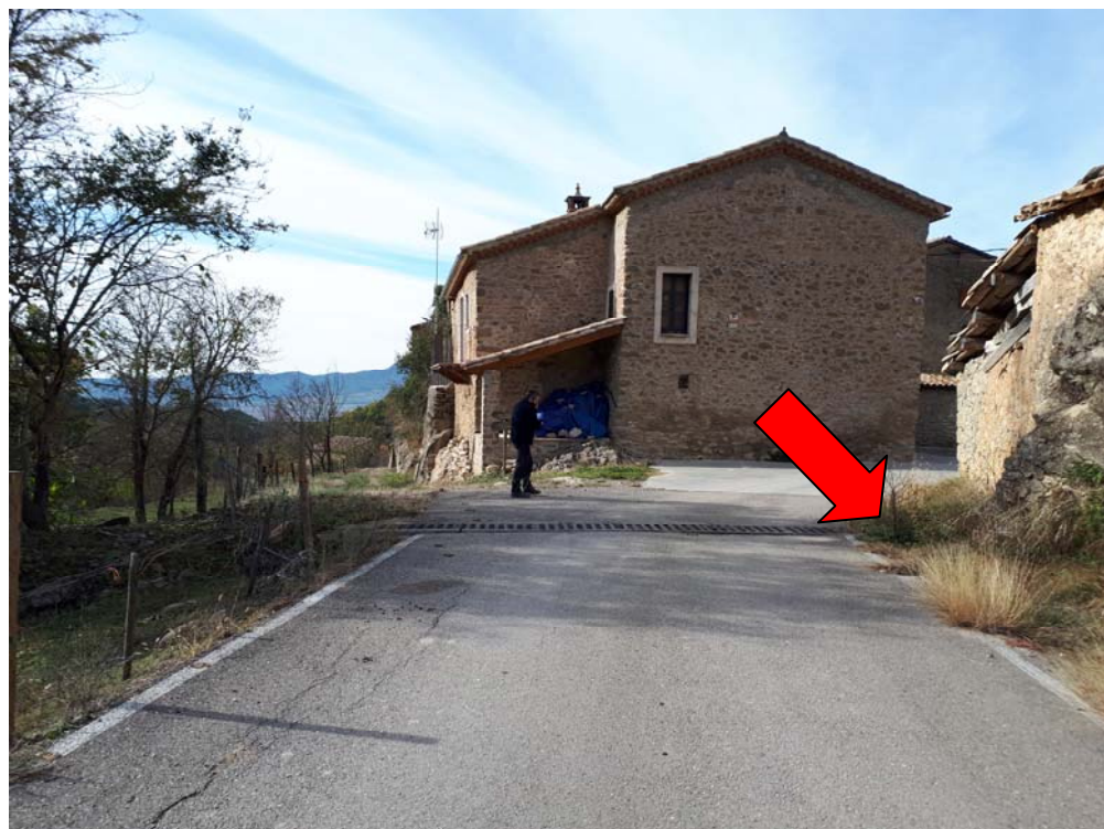
13 Tram d'arribada de la canonada d'abastament en baixa i connexió a la nova xarxa d'aigua potable a l'entrada al nucli de la Valldan
