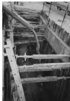
VERTIDO DE HORMIGÓN DE RECUBRIMIENTO
