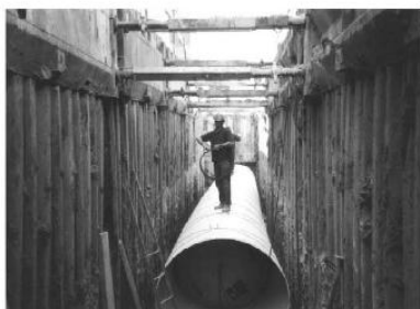
COLOCACIÓN TUBERÍA DE PVC. (RIB-LOC)
