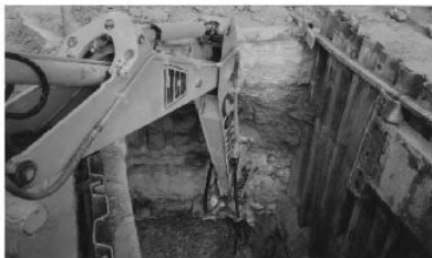
DEMOLICIÓN MECÁNICA EN ZANJA
