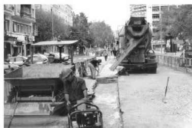
VERTIDO DE HORMIGÓN DE FIRME
