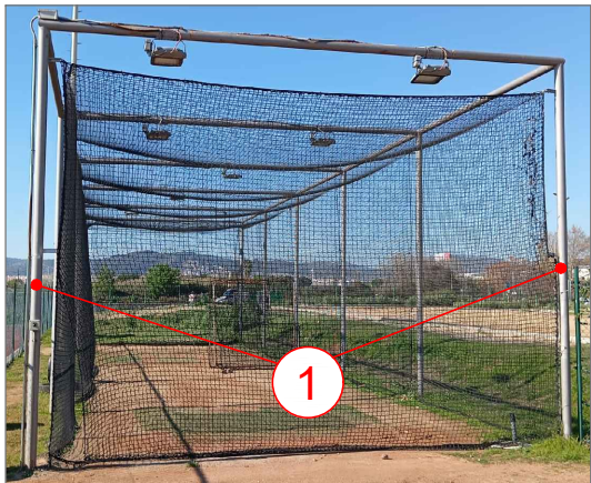
1 Proteccions zona de bateig Camp de Beisbol/Softbol
