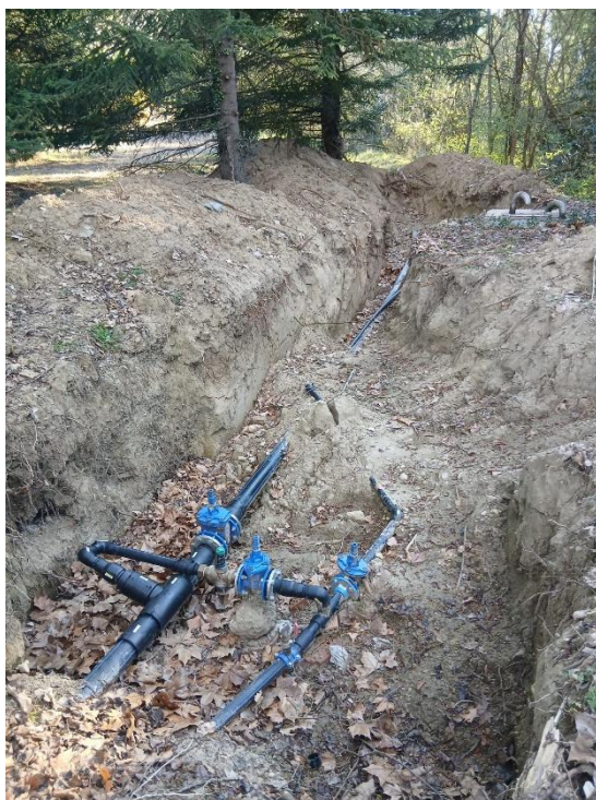
Fotografia 1: Vista del by-pass existent a Saderra.
