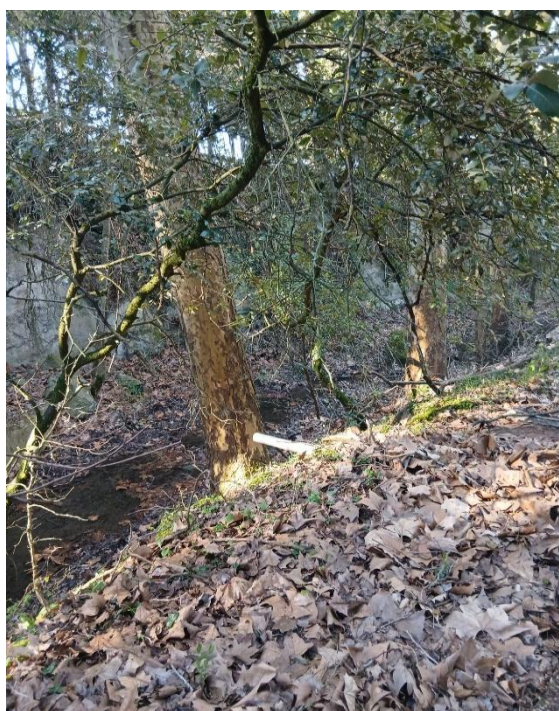
Fotografia 6: Vista del sobreeixidor del bombament existent.
