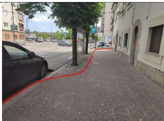
Tram de canalització per vorera darrera la parada del bus a la cantonada de la Pl. Mare de Déu de Montserrat
