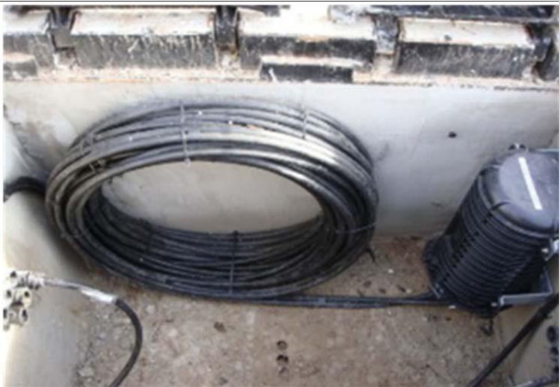
Detall interior pericons tipus C
