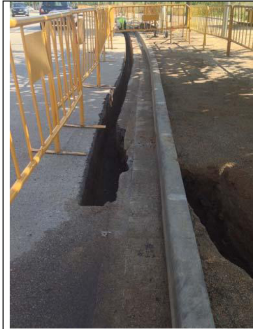
Exemple de canalització Convencional en vies urbanes.
