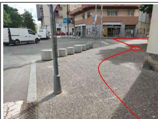
Canalització per vorera fins a la nova arqueta tipus B2 (60x60) a l'inici del carrer Sant Narcís i encreuament del carrer
