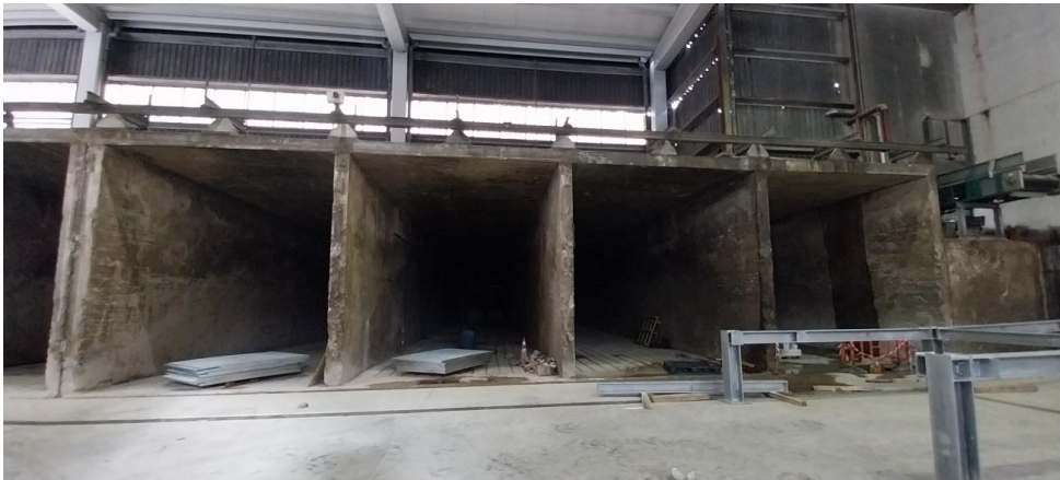
Vista frontal estat actual túnels 9 a 12
