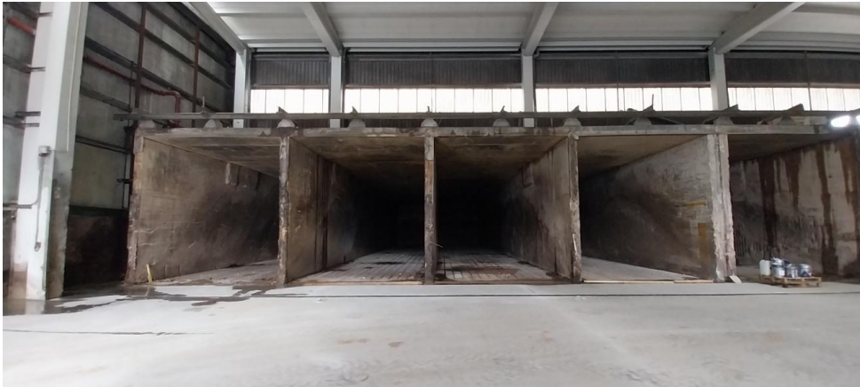
Vista frontal estat actual túnels 1 a 4
