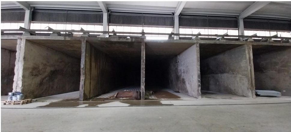
Vista frontal estat actual túnels 5 a 8
