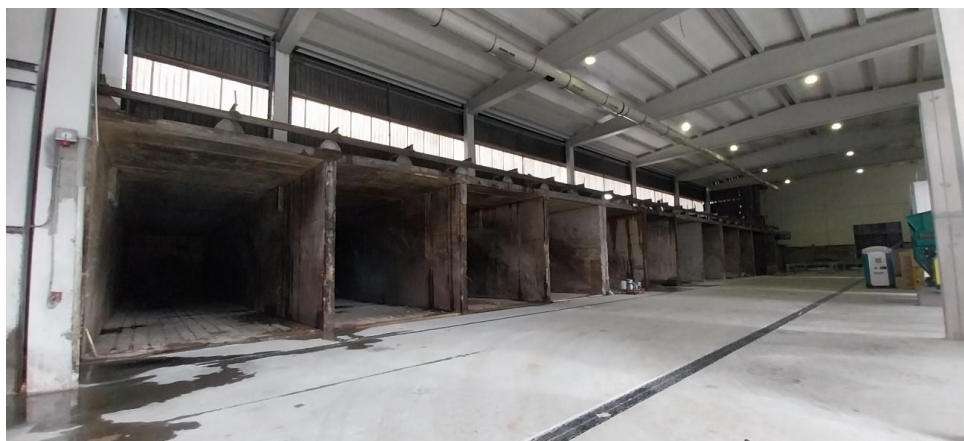
Vista general de la nau de compostatge i dels 12 túnels
