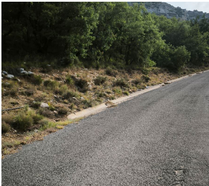
Foto 2. Camí dels Llocs de Feixa. Tram de cuneta de formigó. PK 0+840. Font: pròpia, 2025/08/21
