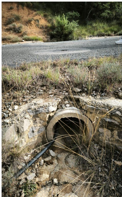
Il·lustració 7. Drenatge existent a restituir i patologies de la calçada que la travessa ODT0+990. Data: 2025/08/21. Font: pròpia.
