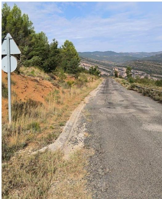
Il·lustració 6. Fotografies de diverses patologies en el ferm del tram del Camí dels llocs de la Feixa. Data: 2025/08/21. Font: pròpia.
