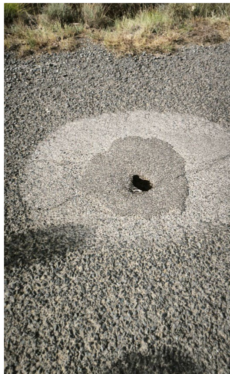
Il·lustració 7. Drenatge existent a restituir i patologies de la calçada que la travessa ODT0+990. Data: 2025/08/21. Font: pròpia.
