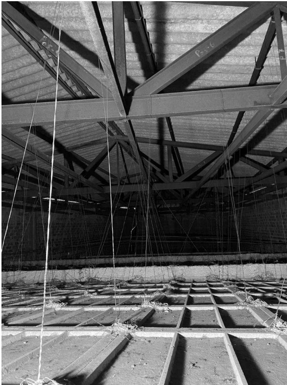
(Imatge 2: Vista de l'estructura de la coberta existent)
