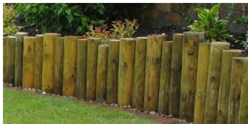
Tutor de fusta de Ø120mm i 25cm d'alçada vistos
