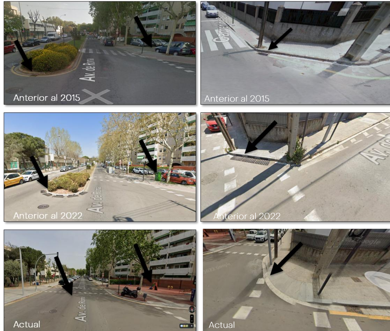
Fig. 4-Evolució temporal del drenatge al creuament de l'avinguda de Roma amb el carrer Sevilla.
