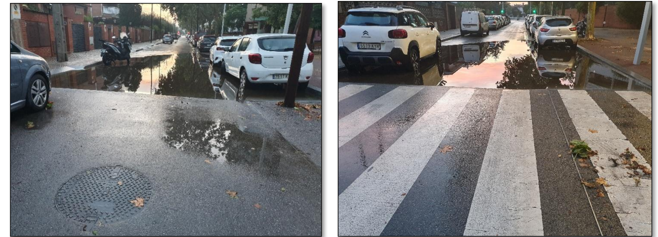
Fig. 5- Acumulació d'aigua després d'un succés de pluja al carrer Sevilla a l'altura del carrer Penedès (esquerra) i a l'altura del carrer Irlanda (dreta) (Font: Ajuntament de Cerdanyola, setembre 2025).
