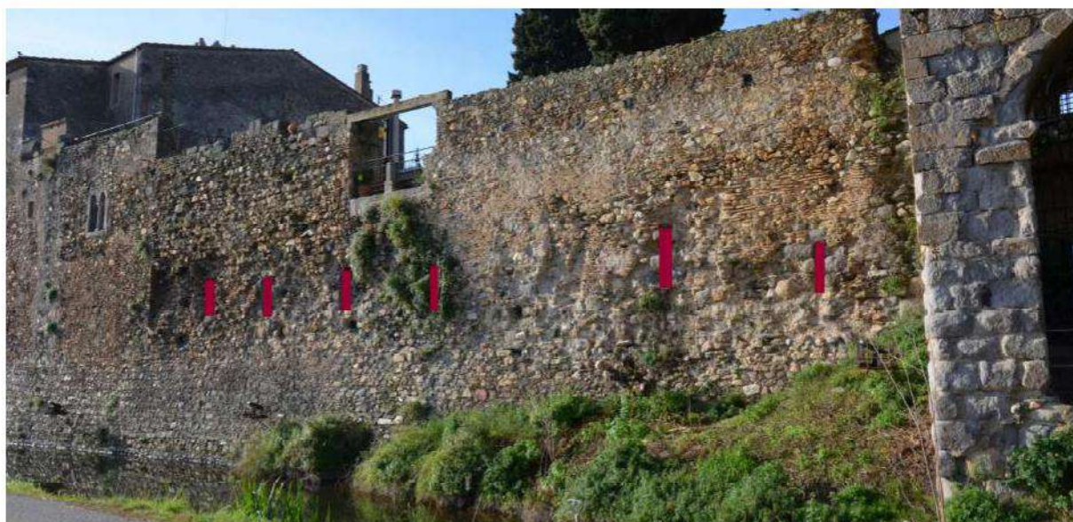
Fig. 9: Línia d'espitlleres del tram de muralla
