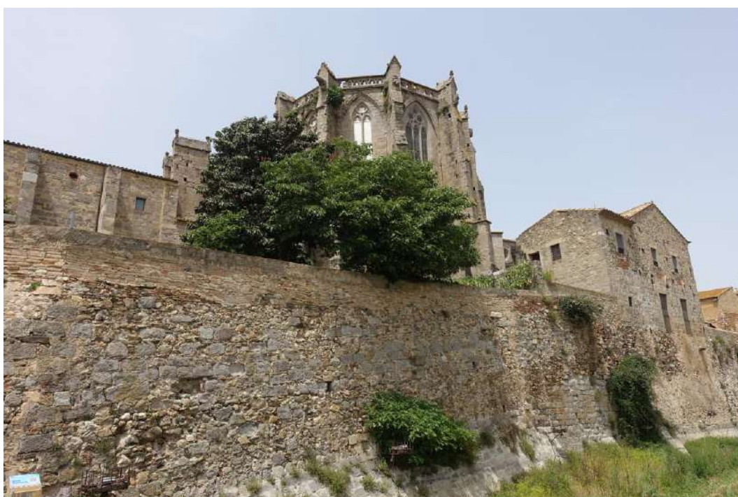
Tram 7 - Visió general de la muralla des de la vessant sud, amb la basílica de Santa Maria en segon pla.
