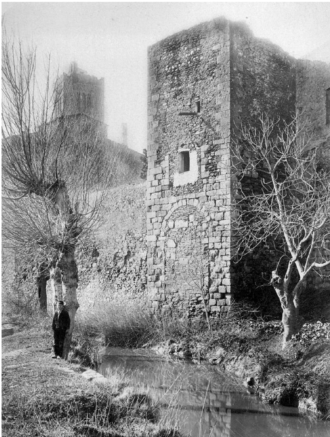
Imatge històrica del portal de la gallarda i del tram de les espitlleres.
