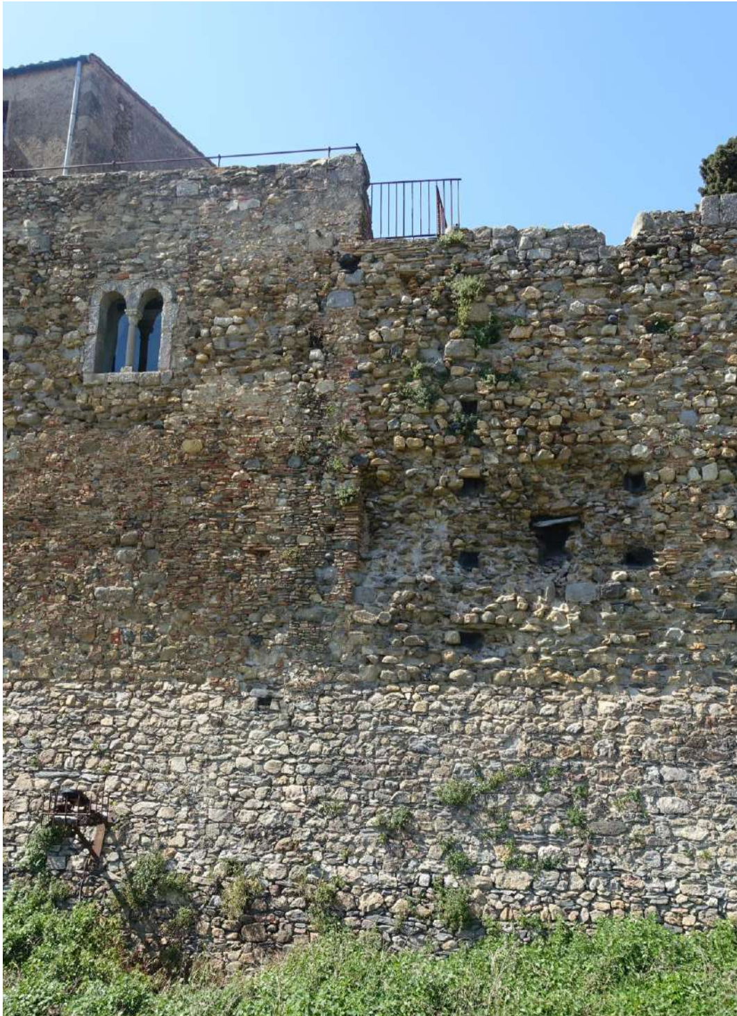
Detall de la vessant sud del tram central
