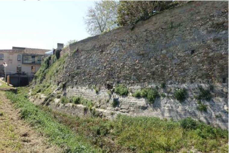
Imatge general de la vessant sud de la muralla
