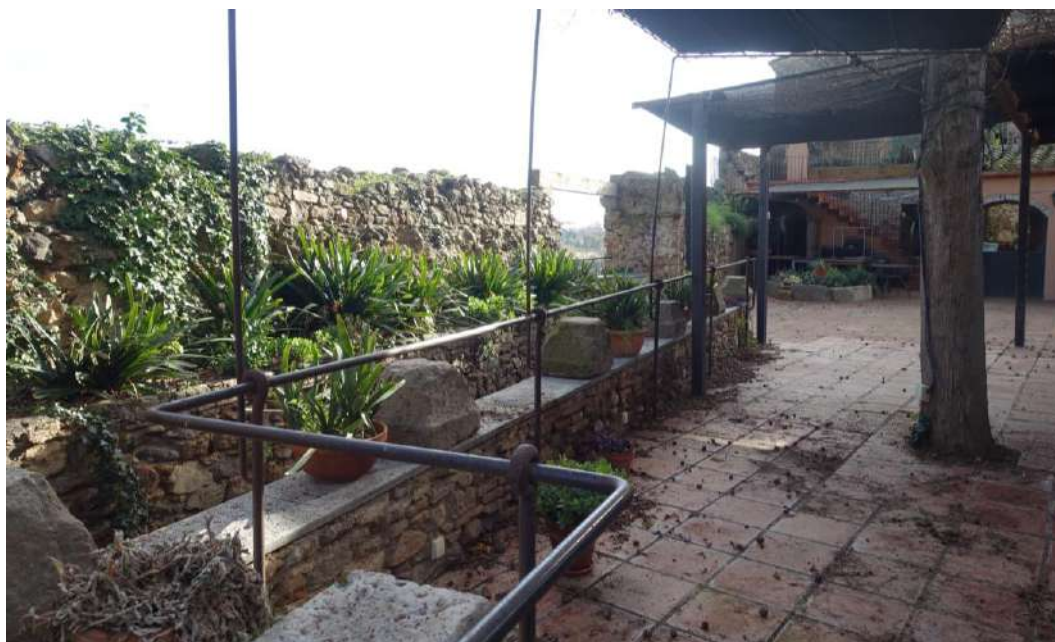
Imatge interna del parament.
