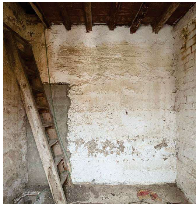
Parament MR1-Nord-Est planta segona
