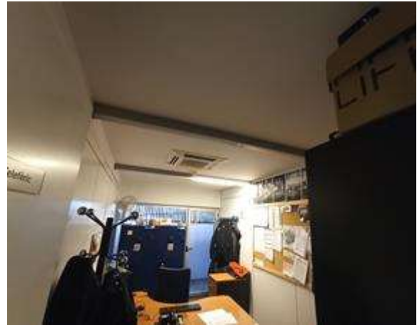
Enllumenat conductor telefèric
