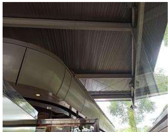
Coberta de zinc
