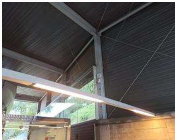
Coberta de zinc
