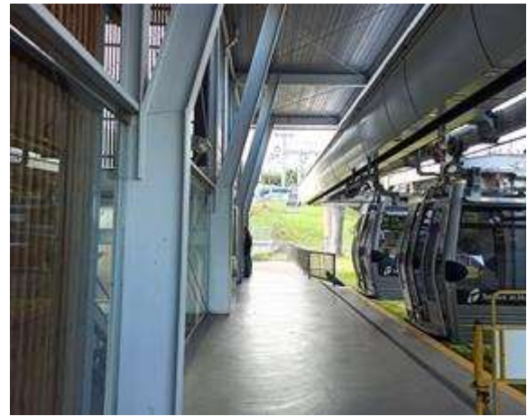
Andana estació Mirador a pintar
