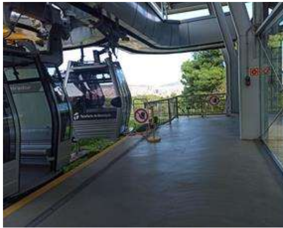
Andana estació Mirador a pintar
