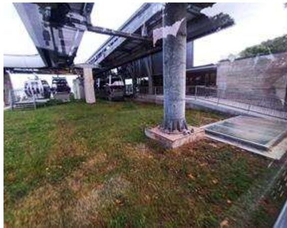
Lluerna i base piona a reparar
