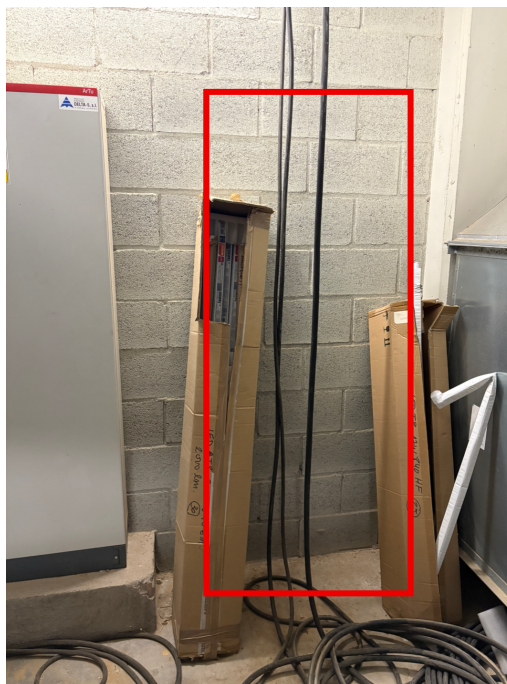
Imatge 4.2. pas vertical d'instal·lacions i ubicació del nou armari
