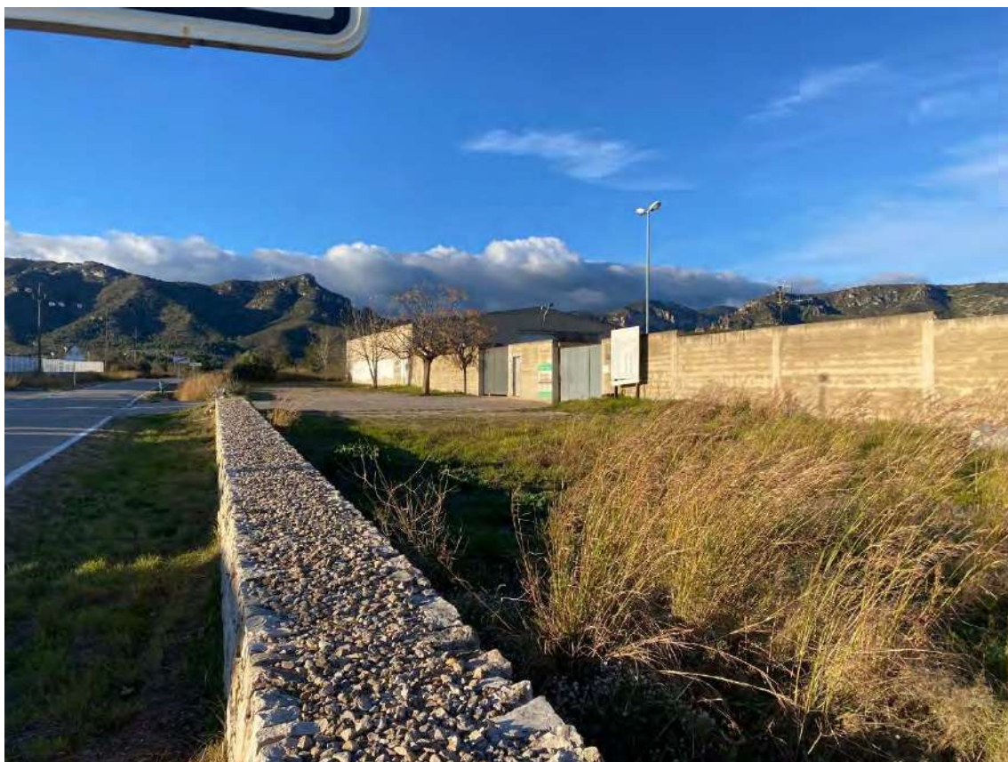
Imatge 8. Vista de la zona del magatzem de la brigada a instal·lar lluminàries
