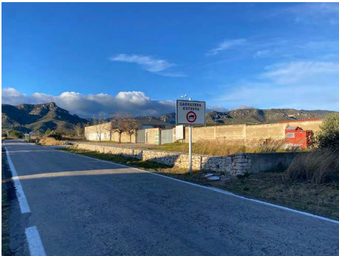
Imatge 7. Vista de l'entrada del magatzem de la brigada on s'instal·laran lluminaries
