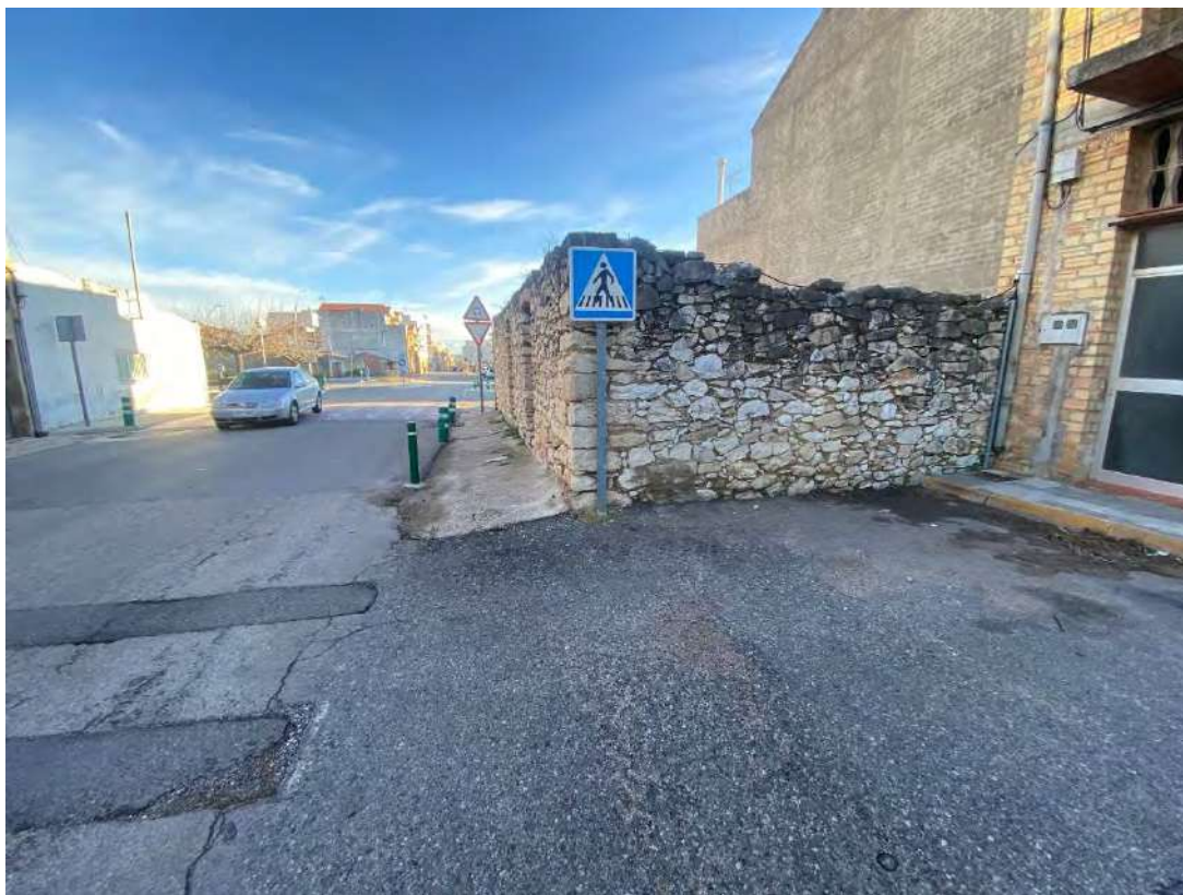
Imatge 1. Vista del carrer de l'edifici de propietat municipal a enderrocar
