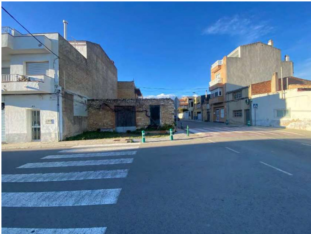
Imatge 3. Vista de l'inici de l'actuació (direcció sortida)
