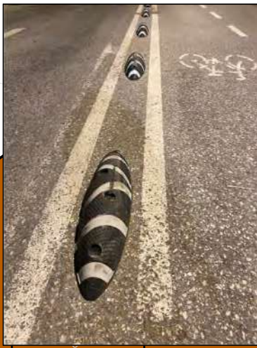
DETALL SEPARADOR CARRIL BICI
