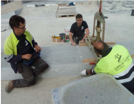
Col·locació de granits continus: Vetllar per no picar les peces entre si amb separadors de cartró p.e.
