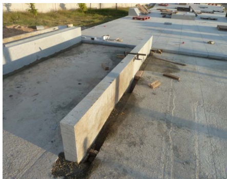
Rail de granit encastat a terra i exemple de connector amb tac químic a granit per formigonat posterior
