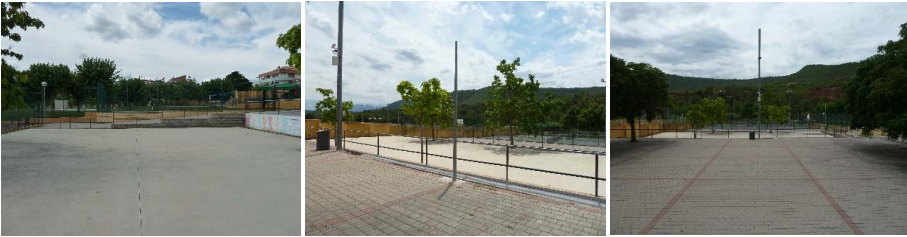
Pista i desnivell existent. Desnivell des de l'espai públic. Vista des de l'espai públic superior
