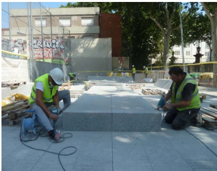
Repàs i arrodoniment d'arestes d'obstacles de granit un cop finalitzada la col·locació i paviments.
