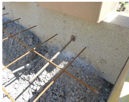
Rail de granit encastat a terra i exemple de connector amb tac químic a granit per formigonat posterior
