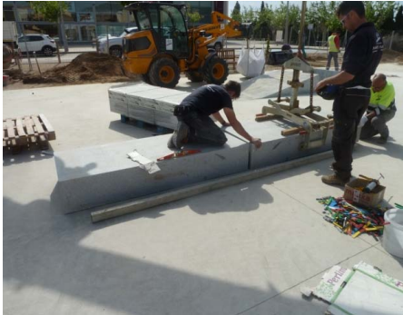
Col·locació de granits continus: Vetllar per no picar les peces entre si amb separadors de cartró p.e.
