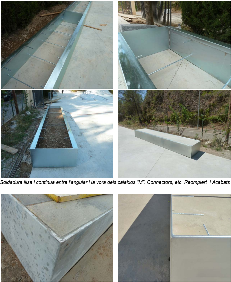
Arestes "arrodonides" a taller abans de galvanitzar, evitant punxes o fils que tallin, per platines i vores.
