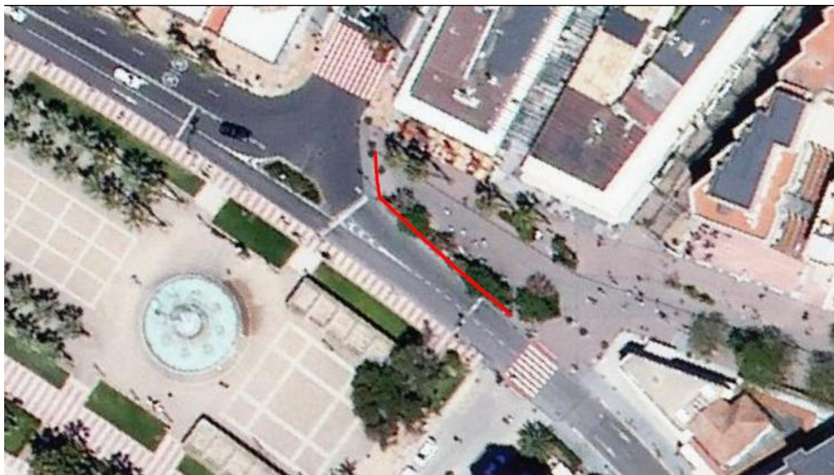
Figura 1- Ubicació de la barana on hi ha un tram afectat.
