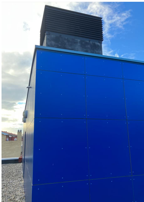
Fotografia 1. Paret on es duu a terme la baixada de cablejat
