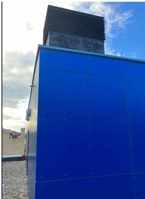
Fotografia 5. Paret on es duu a terme la baixada de cablejat
