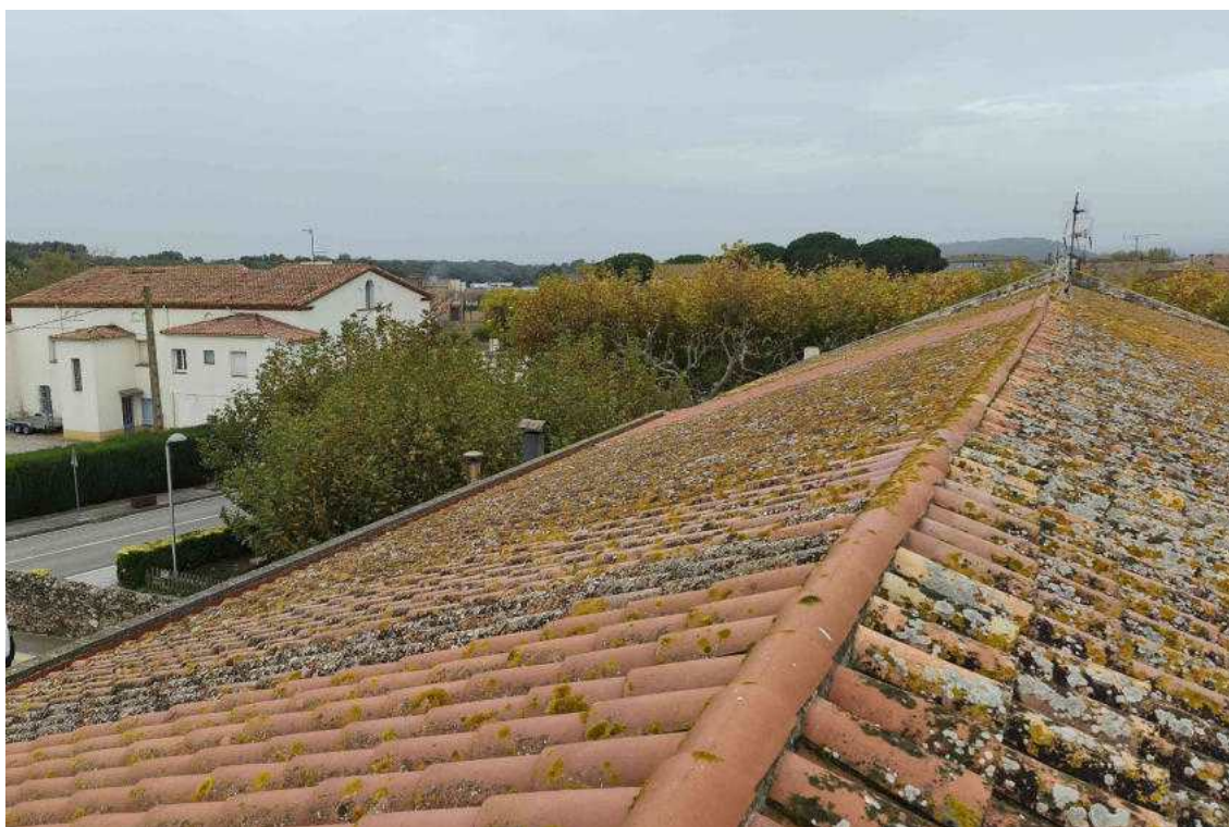
Imatges de la coberta de l'edifici
