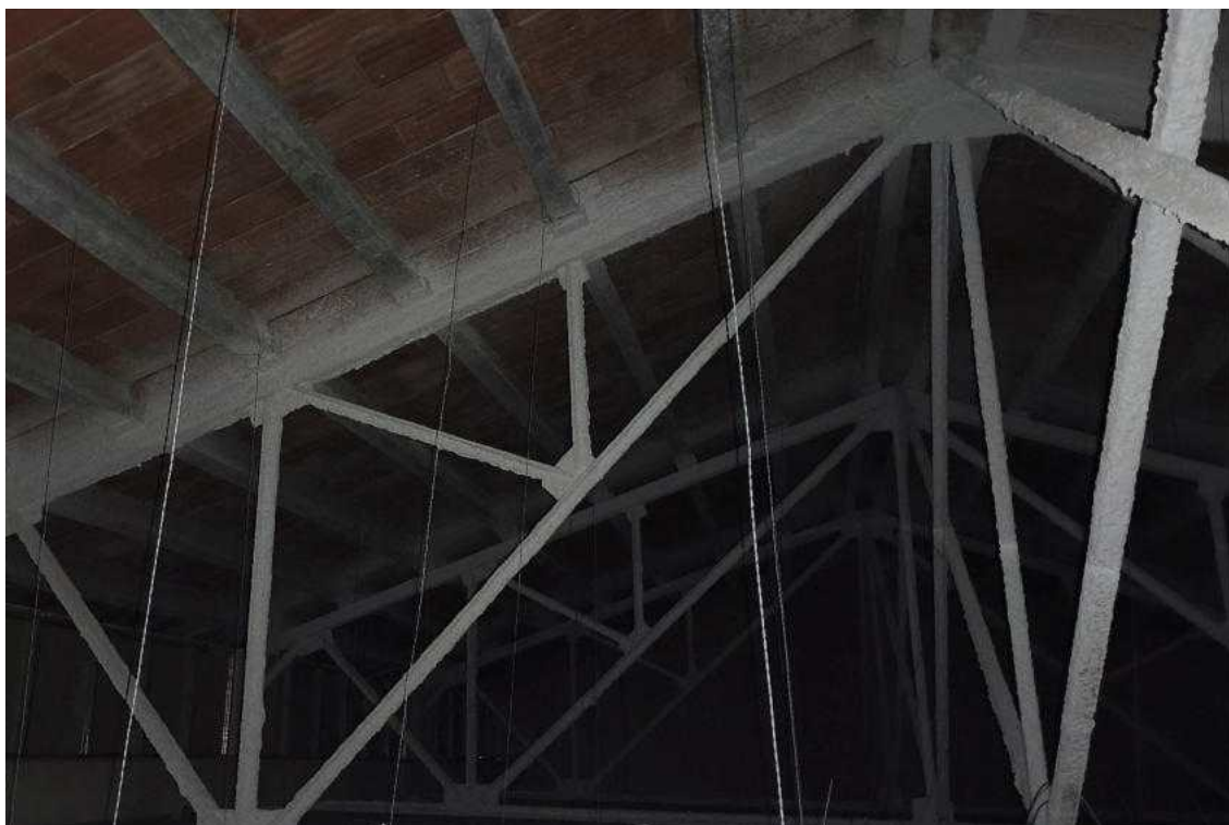
Imatge de l'estructura de coberta
