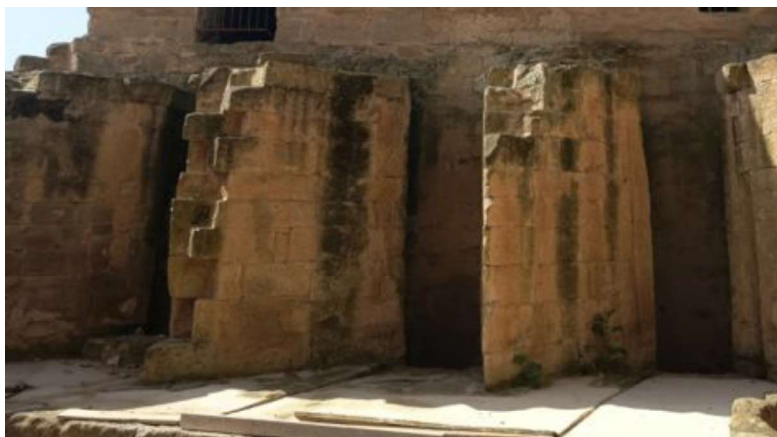
Recobrint biogènic format per fongs i algues a la zona dels cups adossats a la meitat inferior de la façana nord del molí.
