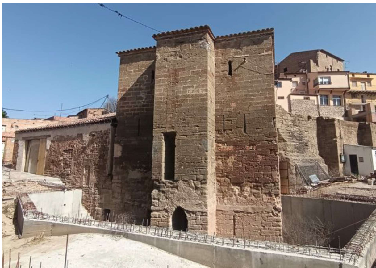
Vistes generals de la façana est, amb la seva portada dovellada, i de la façana nord.
