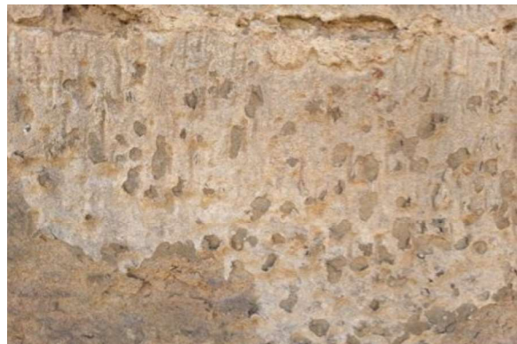
Detalls de la superfície dels carreus afectada per les tensions del recobriment carbonatat que propicien la micro descamacions del suport lapidi.
