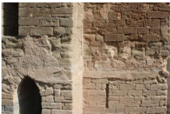
Detall d'algunes restes de revestiments que s'estudiaran amb detall per tal de determinar la necessitat de preservació i tractament. A la dreta, presència de cablejat elèctric que caldria eliminar.
