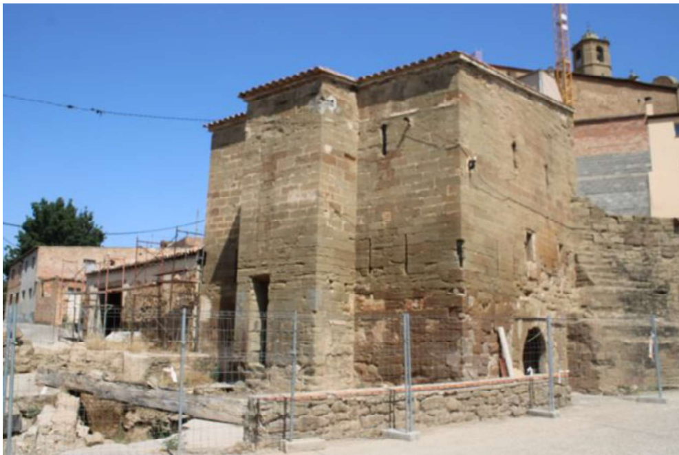
Vista de l'edifici del molí fariner situat entremig del molí d'oli, adossat a l'esquerra en època posterior, i la bassa que assegurava la contínua entrada d'aigua pels cups situats a la cara nord.
