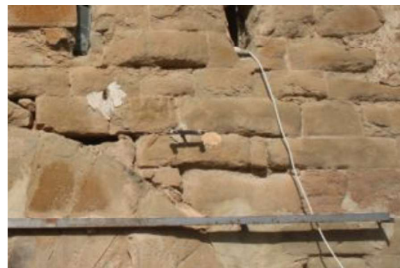
Dues àrees de les façanes sud i est afectades per l'erosió i disgregació dels carreus.
