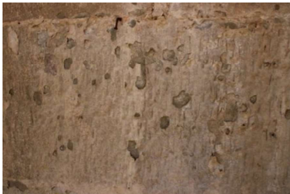
Detalls de la superfície dels carreus afectada per les tensions del recobriment carbonatat que propicien la micro descamacions del suport lapidi.
