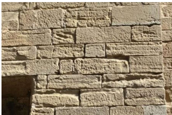
Dues àrees de les façanes sud i est afectades per l'erosió i disgregació dels carreus.
