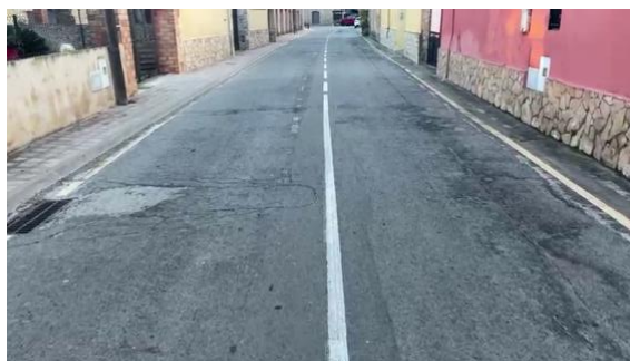
Foto 1 i Foto 2. Deteriorament de la calçada
