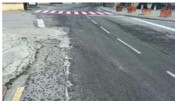
Foto 1 i Foto 2. Deteriorament de la calçada
