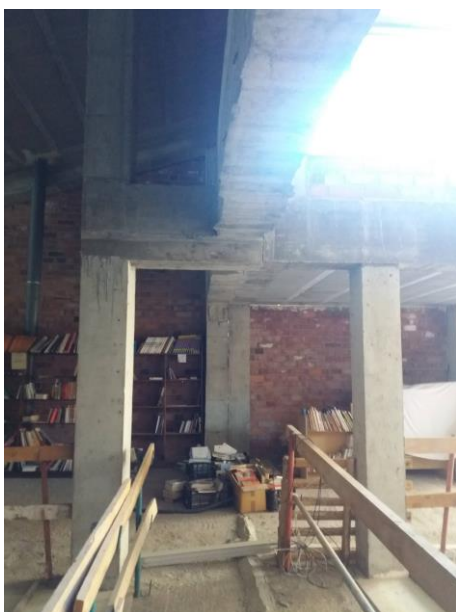
Zona entrada ascensor
