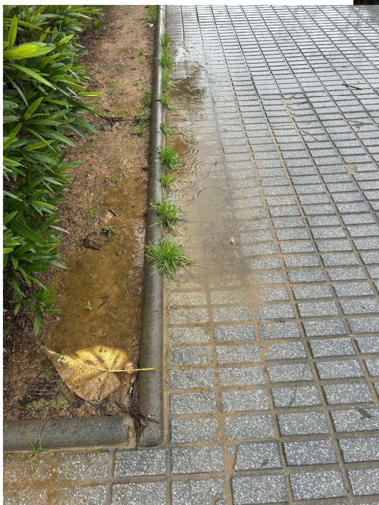
Imatge num 4. Vorada de formigó model jardiner canto rom Mides: 100x20x7 cm. (ample x llarg x alt).
