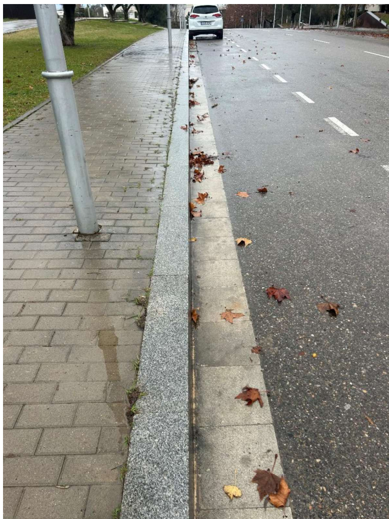
Imatge num 6 Vorada de pedra natural de granet Mides: variable (ample x llarg x alt).
