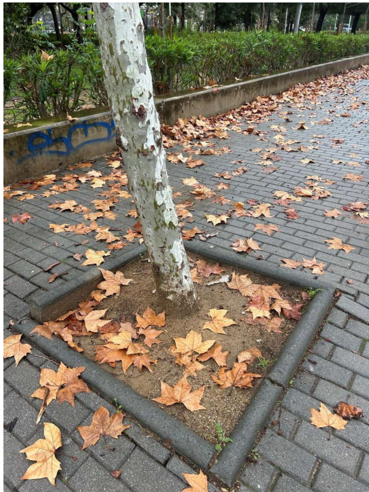
Imatge num 5. Vorada de formigó model jardiner canto rom Mides: 100x20x7 cm. (ample x llarg x alt).
