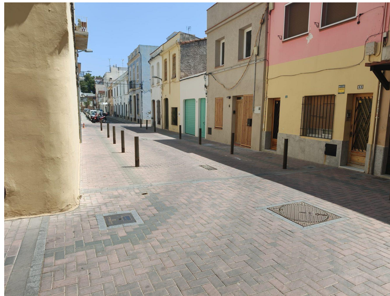
Fotografia 4. Vista longitudinal Carrer Sant Pau on s'observa la reiteració de pilones al llarg del vial.
