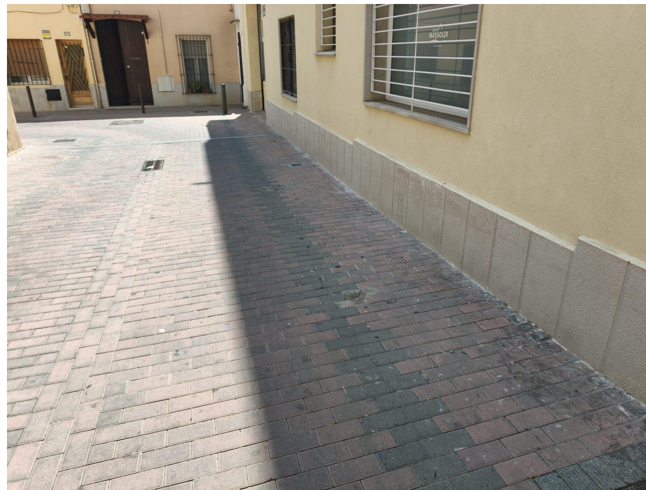
Fotografia 6. Vista del paviment existent a la franja de façana i de diversos punts alterats o reparats.
