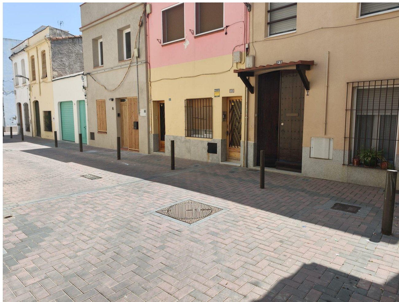
Fotografia 5. Detall de les pilones situades davant de façanes i accessos als habitatges.
