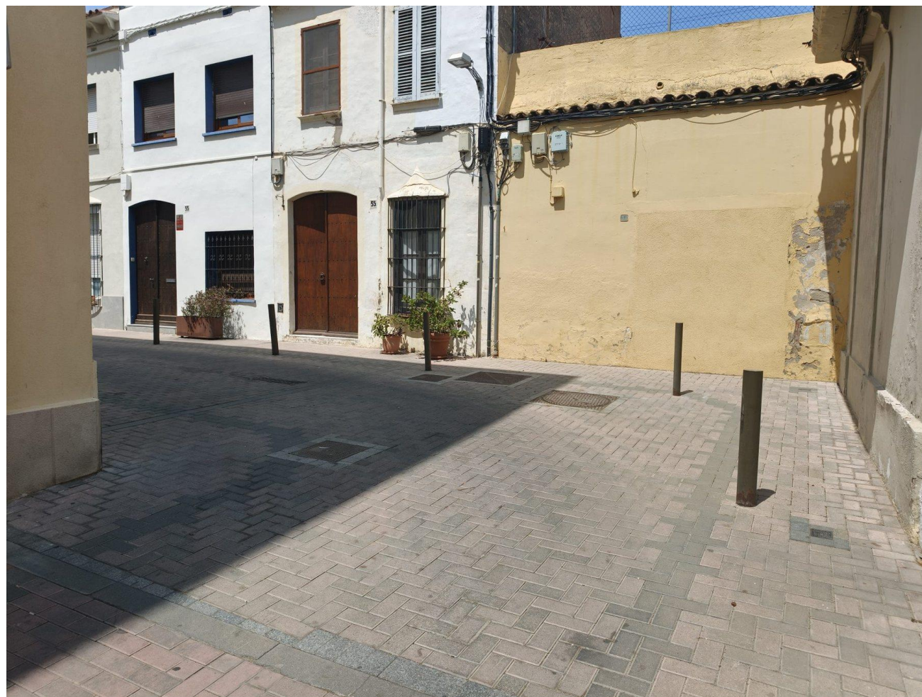
Fotografia 3. Zona de gir situada a l'extrem del carrer, amb diverses pilones metàl·liques.
