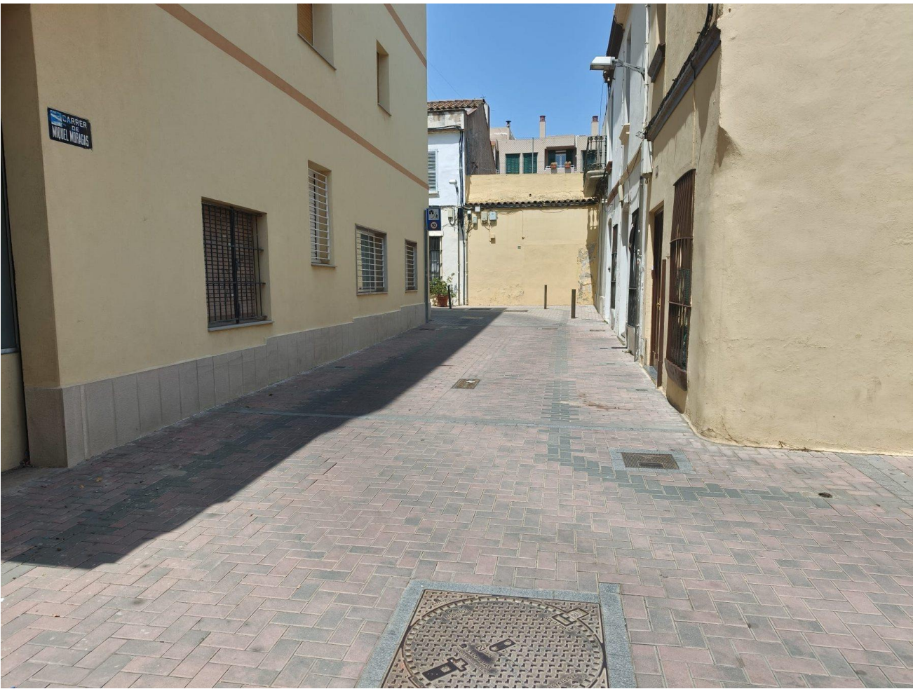
Fotografia 2. Vista longitudinal de l'àmbit pavimentat amb llamborda.
