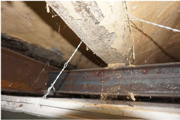
Reforç sostre de planta baixa
