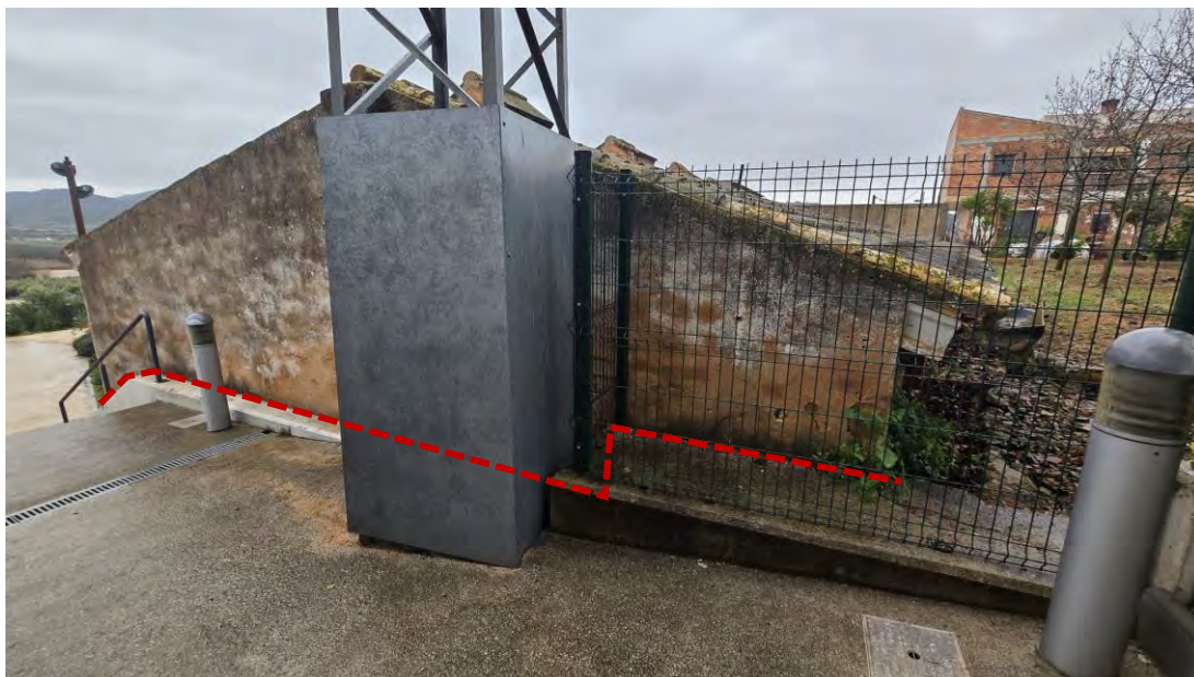
Estat actual façana est.
