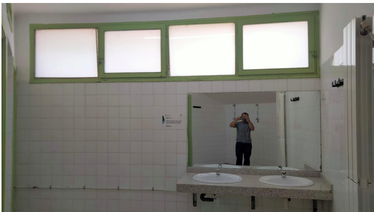
Lavabos interiors dels lavabos
