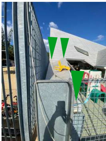
Anclatges a biga existent i mur
