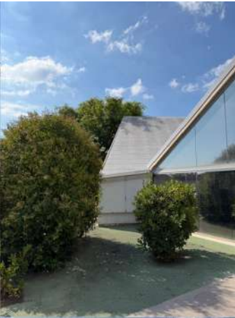
Mur encreuament portic 7 i 8
