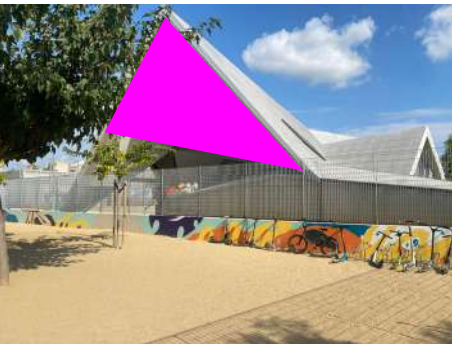
estructura inoxidable amb panells de policarbonat
