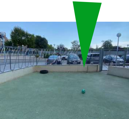
Mur perimetral anclatge mur Pòrtic 9
