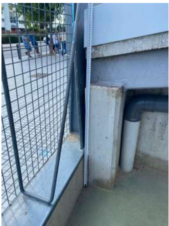
Anclatge a biga existent Cal elaborar planxa registrable per tapar baixant
