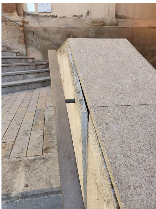
17. Revestiment del mur de les escales d'accés a l'església (mur C)
