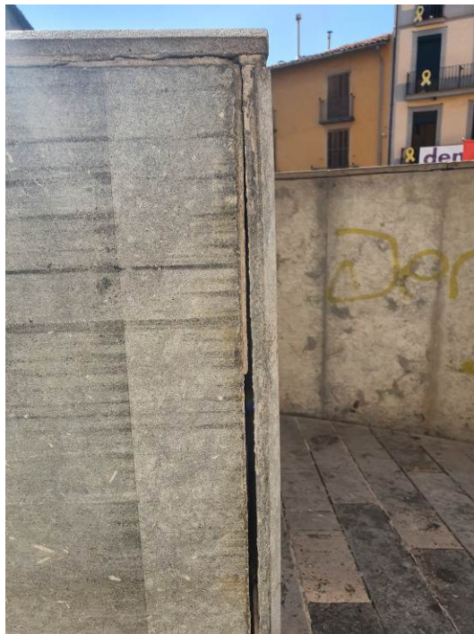
19. Revestiment del mur de les escales d'accés a l'església (mur D)
