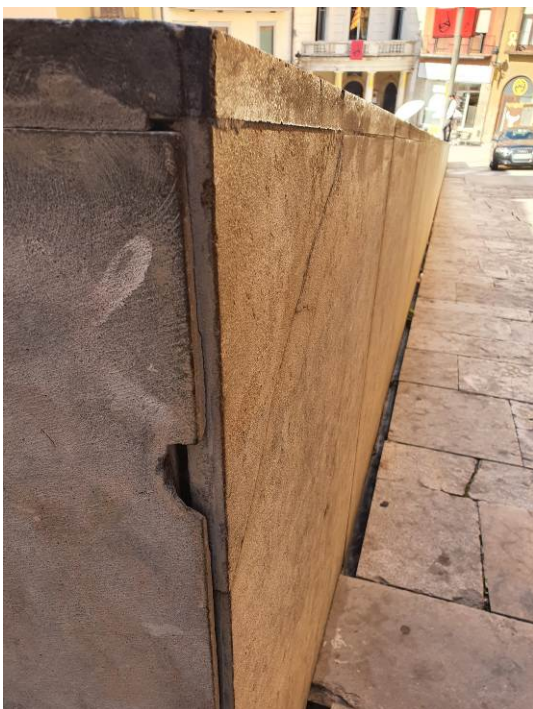
16. Revestiment de la "barana" de la plaça de Sant Pere (mur A)
