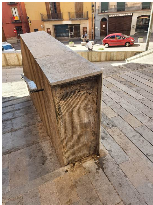
21. Revestiment del mur de les escales d'accés a l'església (mur C)
