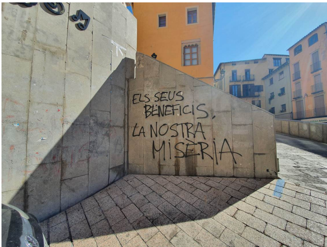
7. Mur a les escales i accés a l'església (murs D i E)
