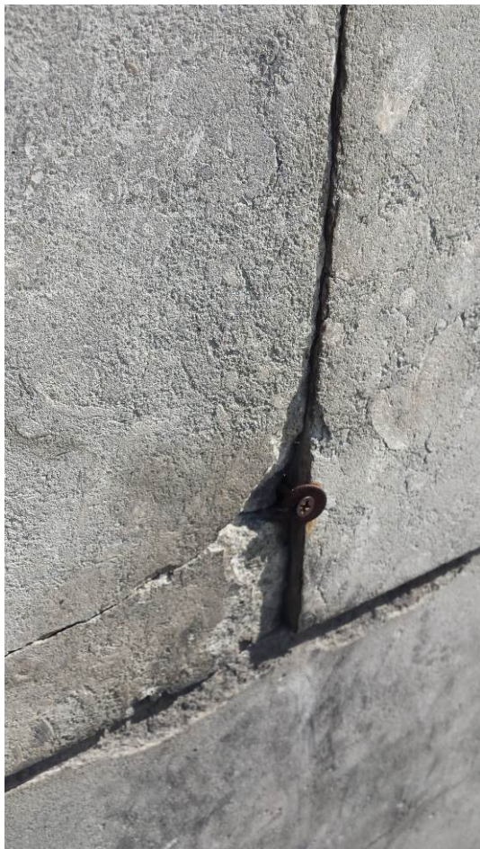
28. Detall de fixació de placa amb cargol (mur A)
