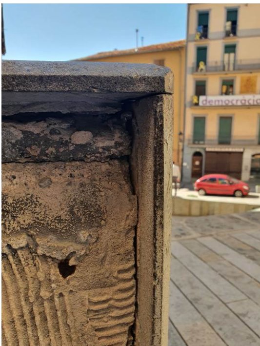
20. Revestiment del mur de les escales d'accés a l'església (mur C)
