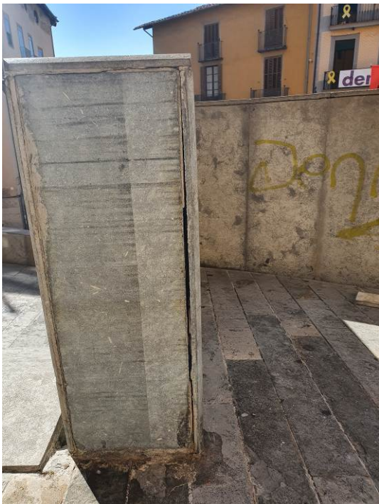
18. Revestiment del mur de les escales d'accés a l'església (mur D)
