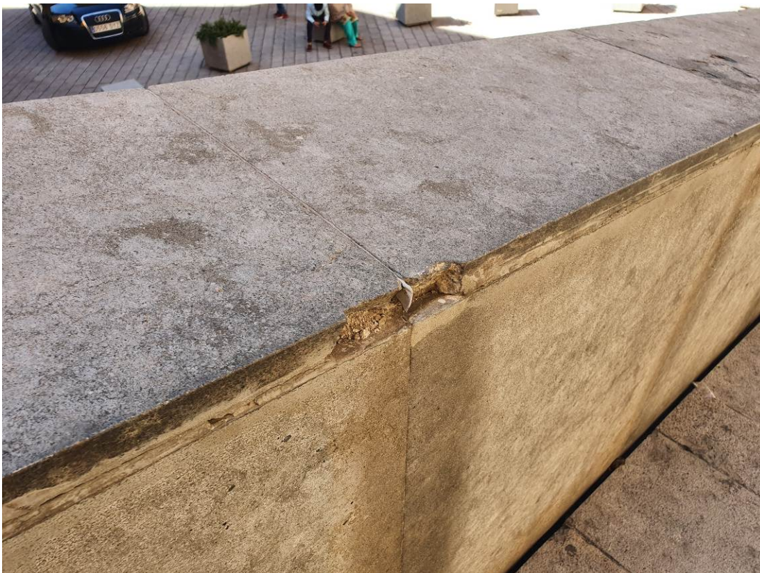
15. Detall del revestiment superior de la "barana" de la plaça de Sant Pere (mur A)
