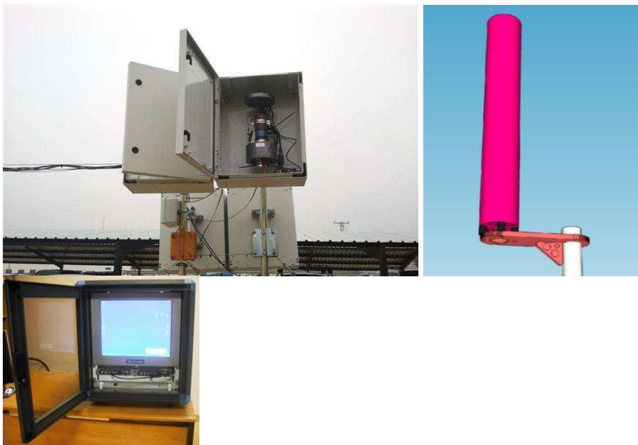
Detalles de los equipos de la red AED+H10
