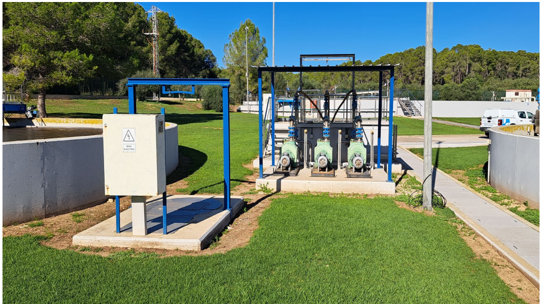
Zona per construir la nova caseta
