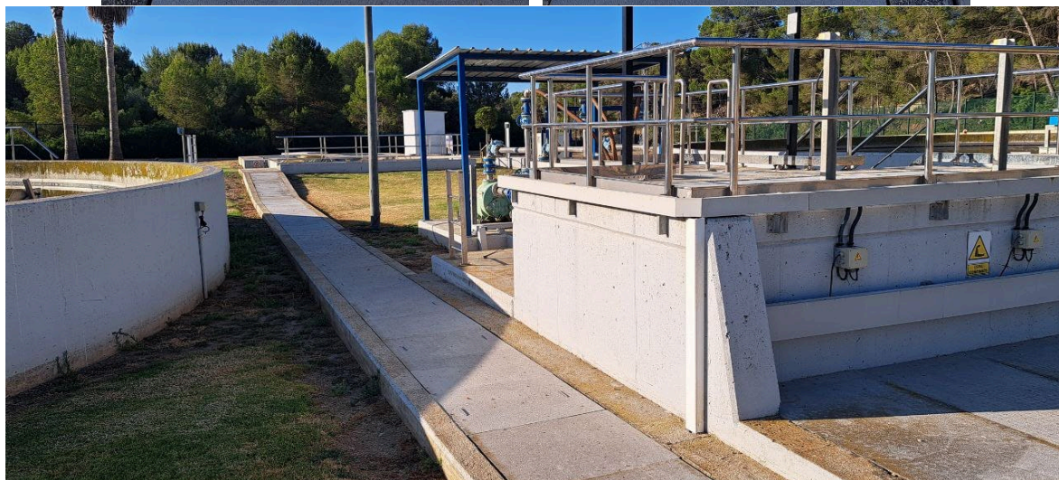
Recorregut de la galeria per on passar la nova escomesa
