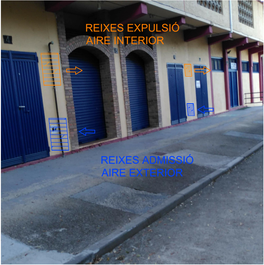
FOTOMUNTATGE REIXES EXTERIORS DE VENTILACIÓ
