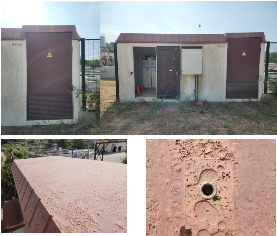
Accés al centre de mesura i transformació. La imatge mostra les condicions de retirada del transformador i de les cel·les existents, així com l'entrada dels nous equips.
