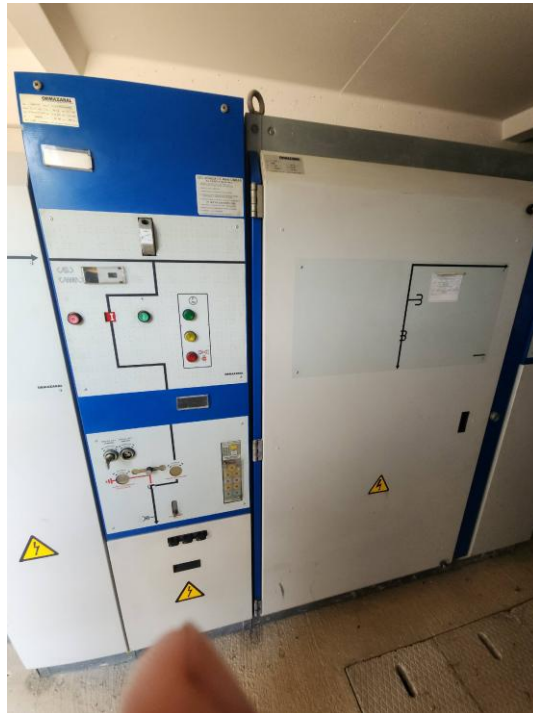
Fotografia 5. Detall de la cel·la de mesura existent
