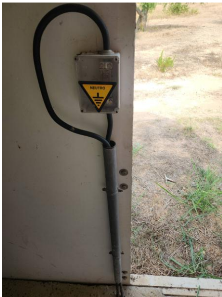
Fotografia 12. Xarxa de posada a terra
