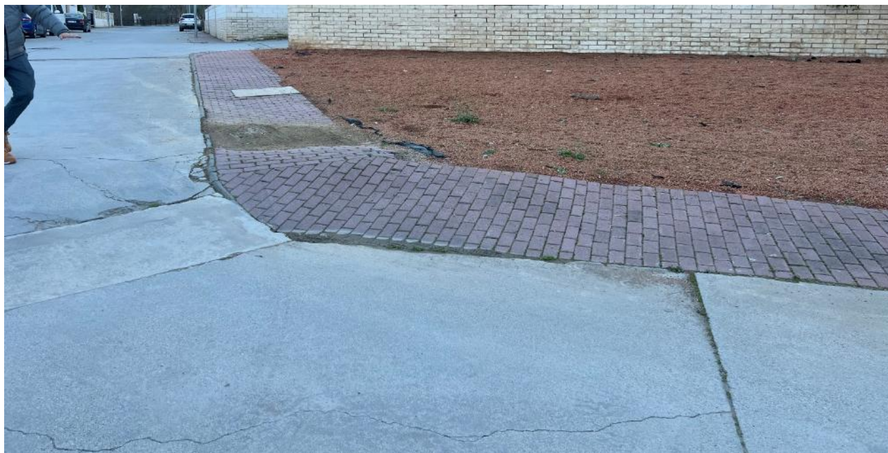
Imatge 2. Assentament de calçada i vorera.
