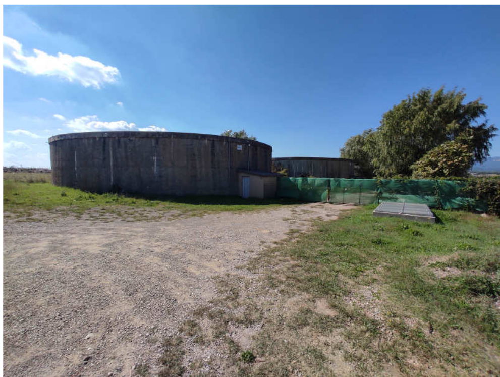
Dipòsits CAL VENTURA 1 I 2
