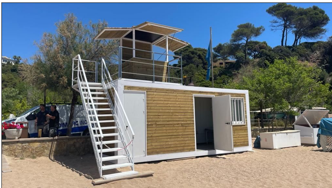
Caseta de salvament (en fase de muntatge)
