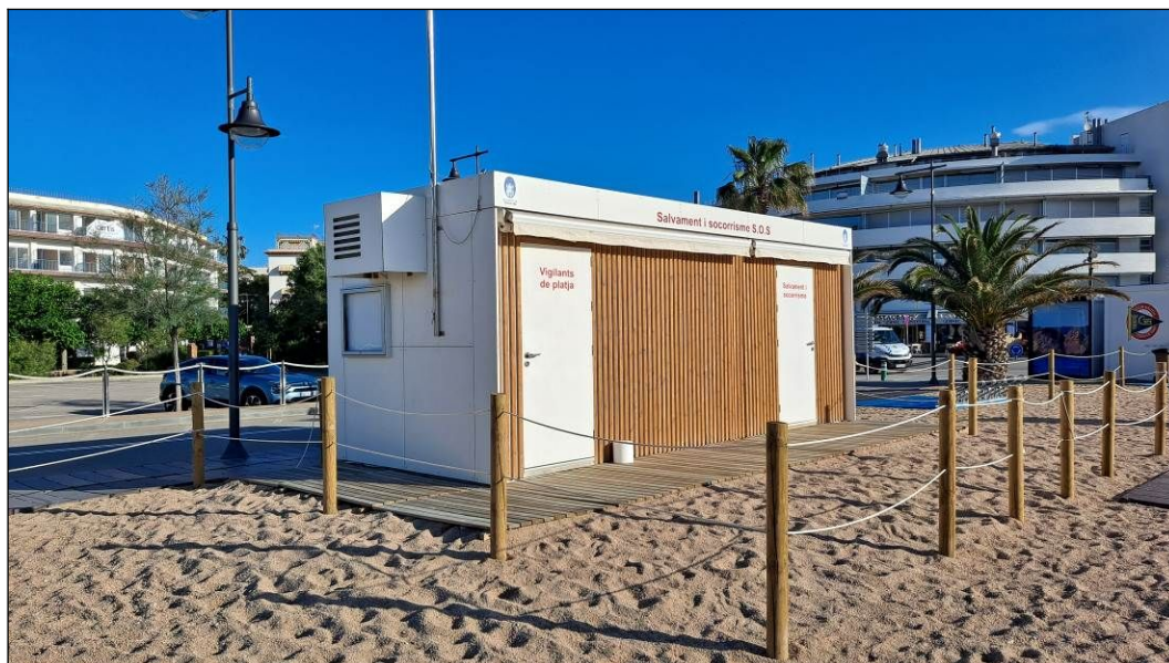
Caseta de salvament (en fase de muntatge) formada per dos cossos
