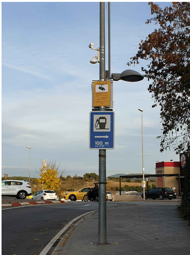
EXEMPLE D'EMPLAÇAMENT DE CÀMERA A FANAL
