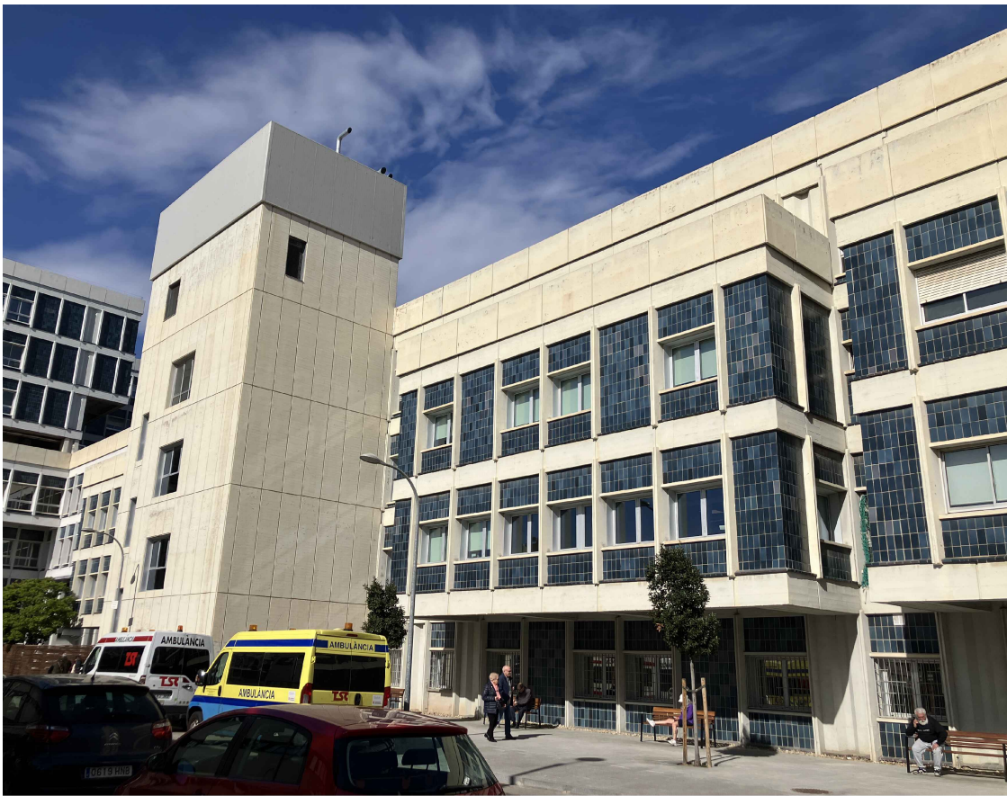
Fotografies façana SE Edifici 2
