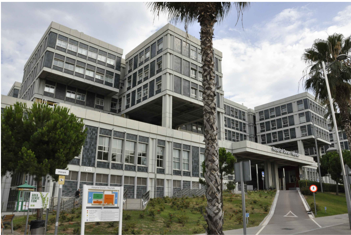
Fotografies façana NO
