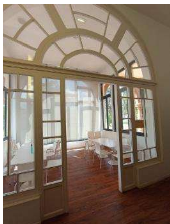
Edifici Mancomunitat 2 (M2) - tancaments
