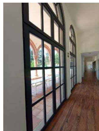
Edifici Mancomunitat 2 (M2) - tancaments
