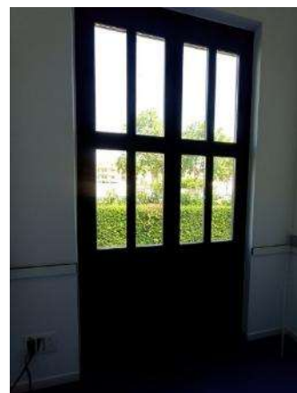
Edifici Mancomunitat 2 (M2) - tancaments
