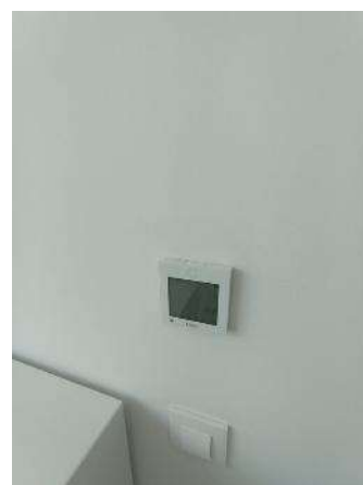
Edifici Annex 2 - Acabats
