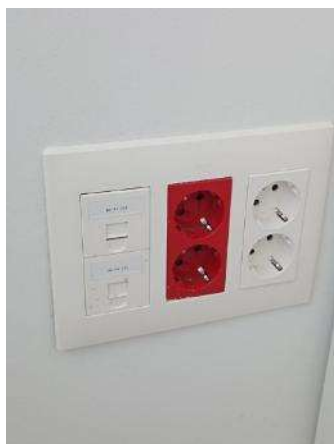
Edifici Annex 2 - Acabats
