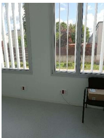
Edifici Annex 2 - Acabats
