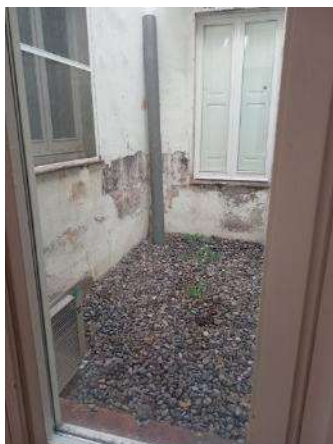
Edifici Mancomunitat 2 (M2) - patis interiors
