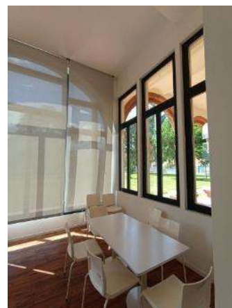
Edifici Mancomunitat 2 (M2) - tancaments
