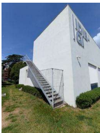
Edifici Annex 2 - accés a coberta
