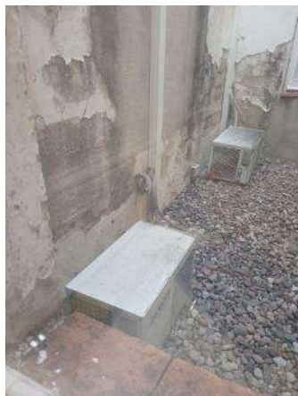
Edifici Mancomunitat 2 (M2) - patis interiors
