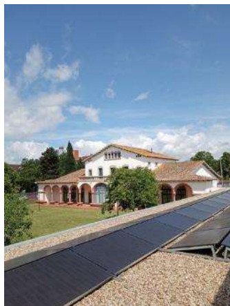
Edifici Annex 2 - plaques fotovoltaïques
