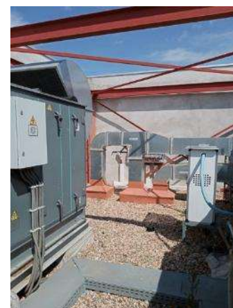
Edifici Annex 2 - sala tècnica coberta
