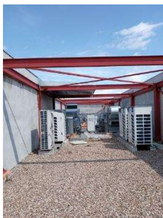
Edifici Annex 2 - sala tècnica coberta
