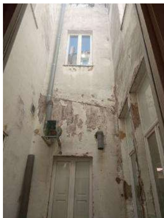
Edifici Mancomunitat 2 (M2) - patis interiors
