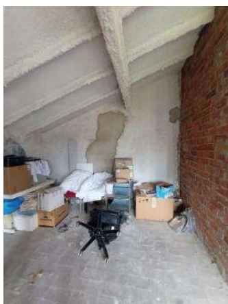
Edifici Mancomunitat 2 (M2) - interiors de planta 2a a rehabilitar
