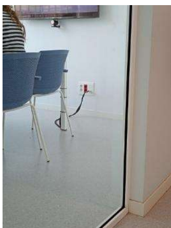
Edifici Annex 2 - Acabats
