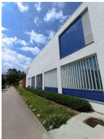
Edifici Annex 2 - façana SUD
