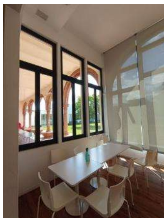
Edifici Mancomunitat 2 (M2) - tancaments
