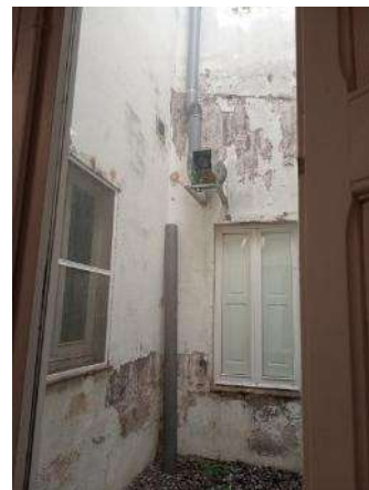
Edifici Mancomunitat 2 (M2) - patis interiors
