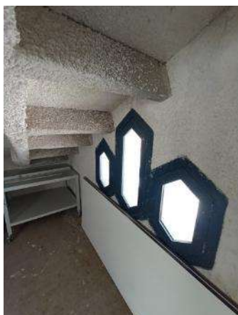
Edifici Mancomunitat 2 (M2) - tancaments
