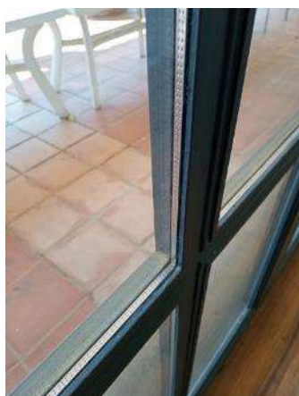
Edifici Mancomunitat 2 (M2) - tancaments
