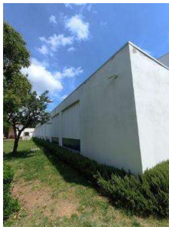
Edifici Annex 2 - façana NORD
