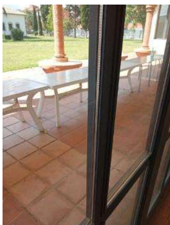
Edifici Mancomunitat 2 (M2) - tancaments
