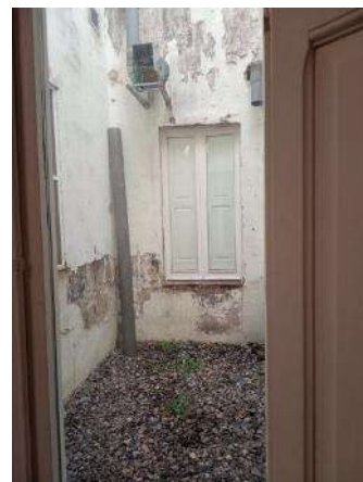
Edifici Mancomunitat 2 (M2) - patis interiors
