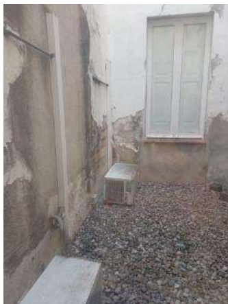
Edifici Mancomunitat 2 (M2) - patis interiors
