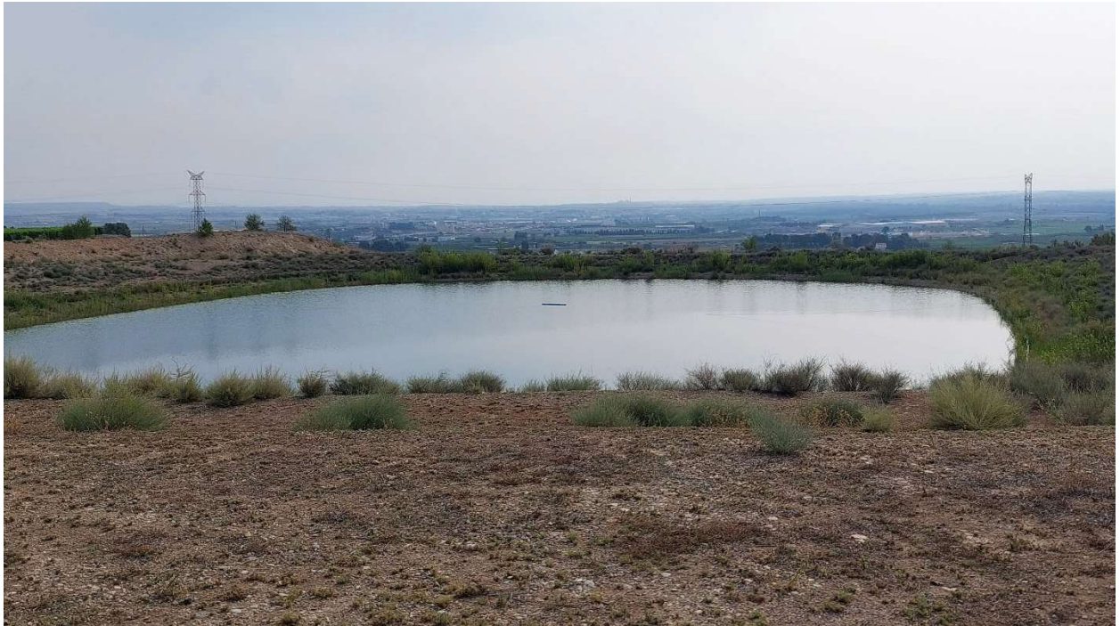
Fotografia 4. Dipòsit primer Soses, ús de boca, 75.000 m 3 .
