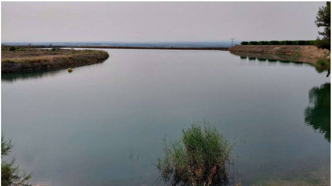
Fotografia 5. Dipòsit segon Soses, ús de boca i reg 170.000 m 3 .
