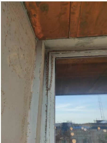
Detalls de l'estat de les finestres per la seva cara exterior
