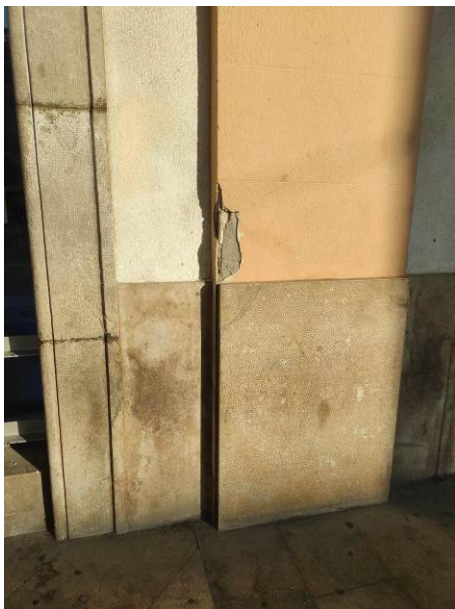
al estat del revestiment de la façana a la Plaça de la Vila afectat per humitats de capil·laritat
