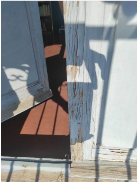
Estat de bastiments i fulles, cara exterior.
