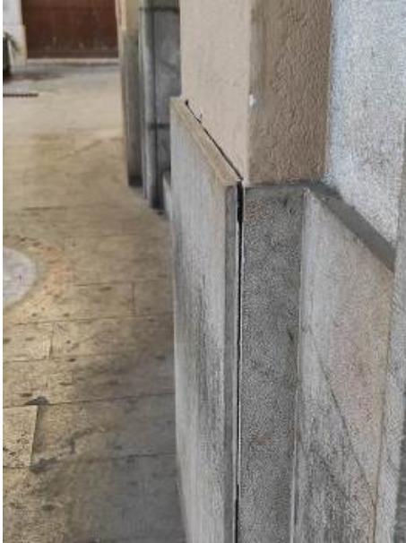
Aplacat de pedra de sòcol exterior parcialment despreses
