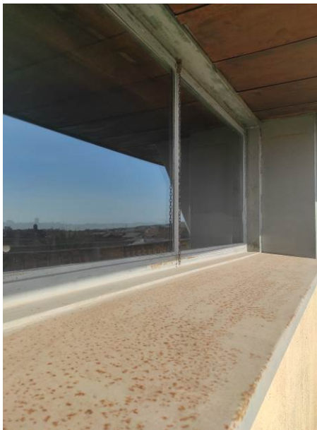
Vista exterior (façana Plaça) finestres sala doble espai
