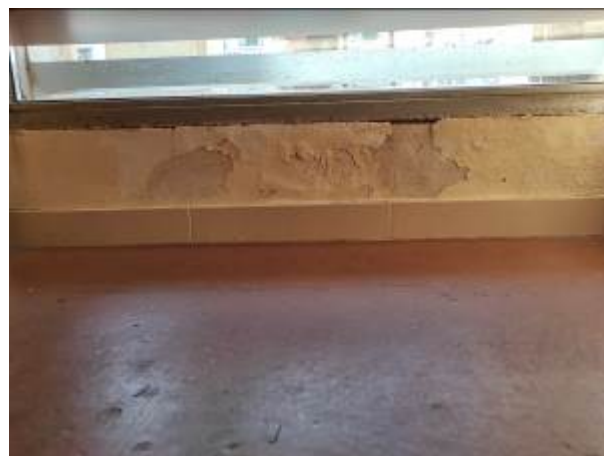
al estat del revestiment de la façana a la Plaça de la Vila afectat per humitats de capil·laritat
