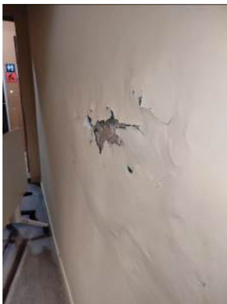
Afectació, a tall d'exemple, de les mateixes humitats a la cara interior del mur de façana a la Plaça de la Vila.
