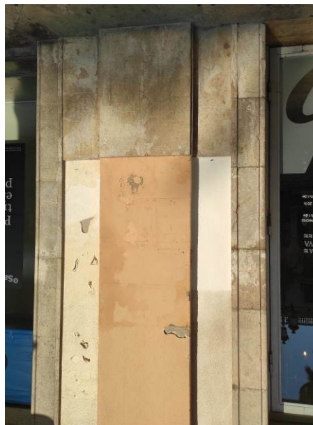
al estat del revestiment de la façana a la Plaça de la Vila afectat per humitats de capil·laritat
